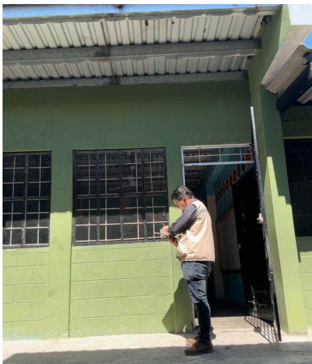
Ilustración 1 Supervisión de rehabilitación del CEB Miguel Morazán
