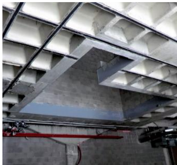
Ilustración 20 Refuerzo a flexión positiva
