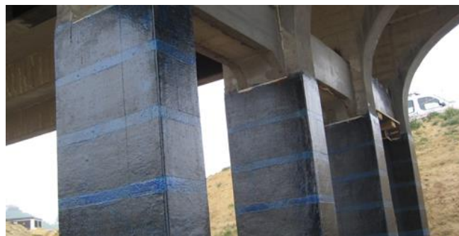
Ilustración 27 Refuerzo a confinamiento con fibra de carbono
