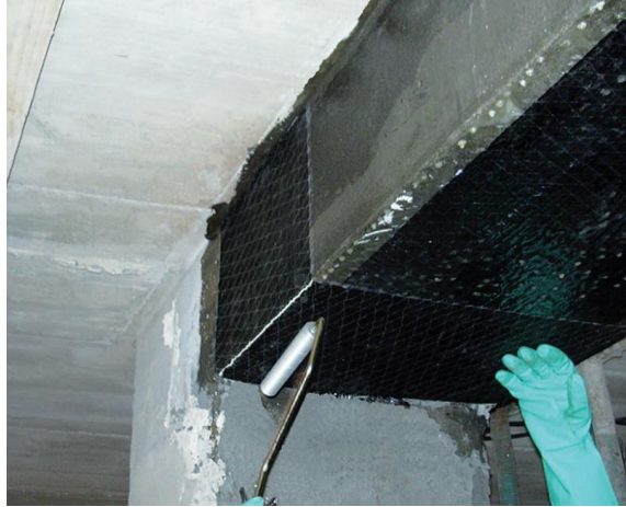
Ilustración 34 Refuerzo a cortante
