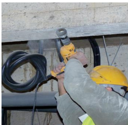
Ilustración 37 Preparación del soporte para una buena adherencia
