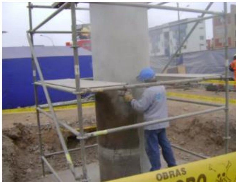
Ilustración 50 Preparación de la superficie
