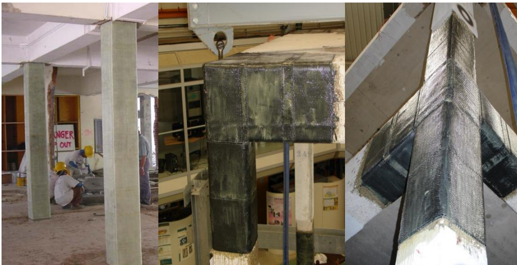
Ilustración 23 Confinamiento con fibra de carbono
