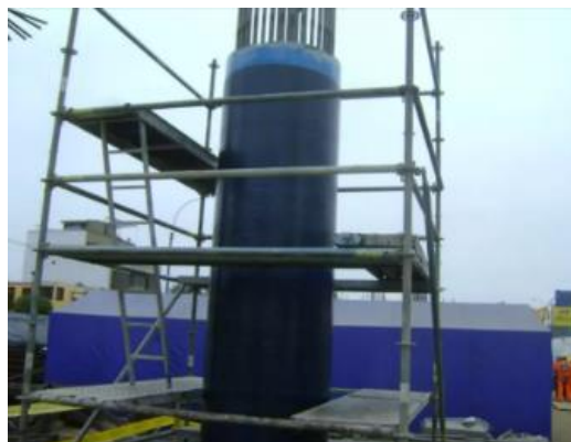
Ilustración 53 Columna circular ya reforzada.
