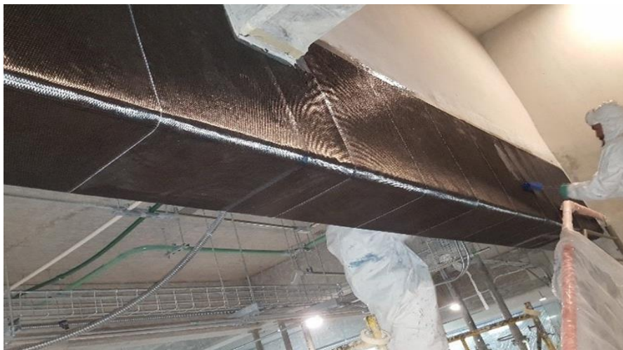
Ilustración 12 Reforzamiento estructural con Fibra de Carbono
