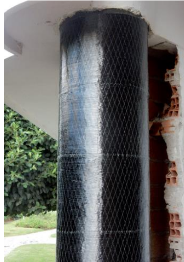
Ilustración 28 Refuerzo por confinamiento
