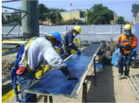
Ilustración 51 Preimpregnación de las fibras
