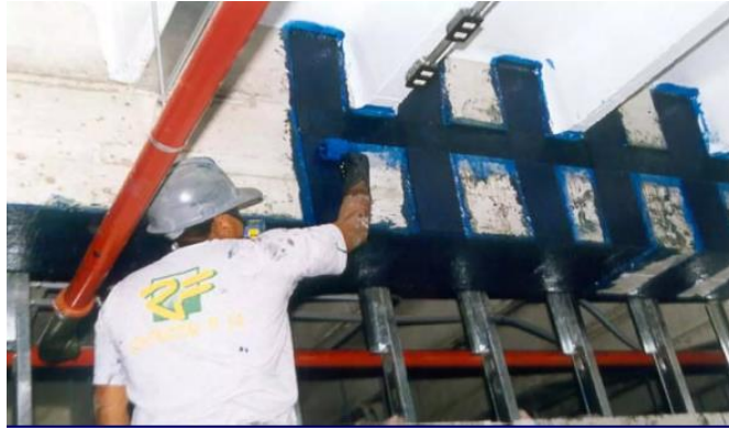
Ilustración 48 Refuerzo a Cortante de las columnas de la torre
