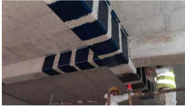
Ilustración 11 Reforzamiento de Vigas con sistema CFRP (Fibra de Carbono)
