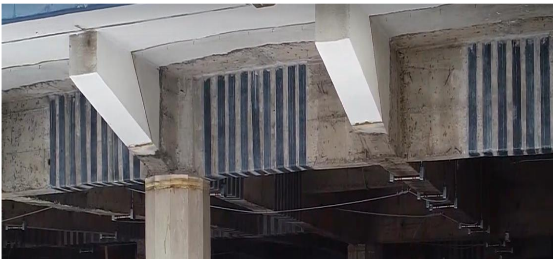
Ilustración 57 Reforzamiento de las vigas del edificio
