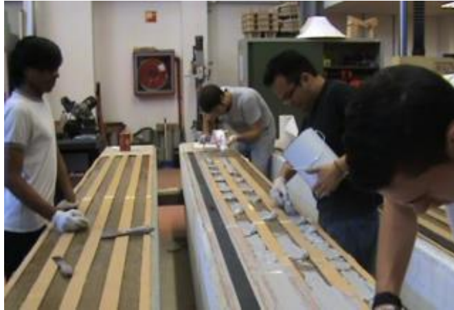
Ilustración 40 Aplicación de la resina epoxi
