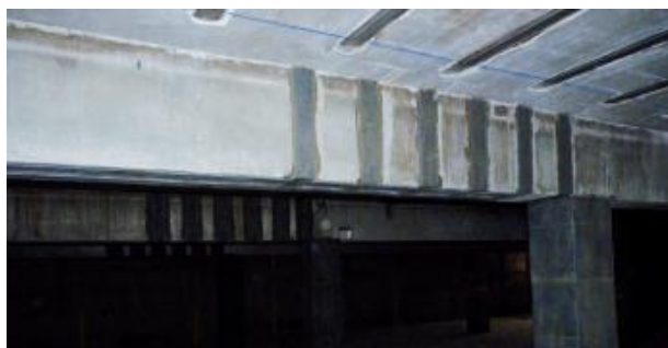
Ilustración 35 Reforzamiento por cortante con CFRP
