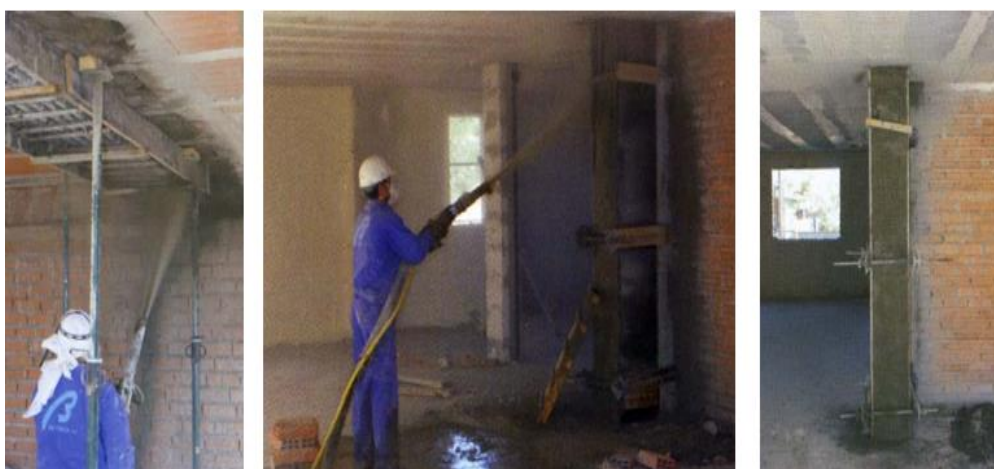
Ilustración 3 Refuerzo mediante concreto proyectado
