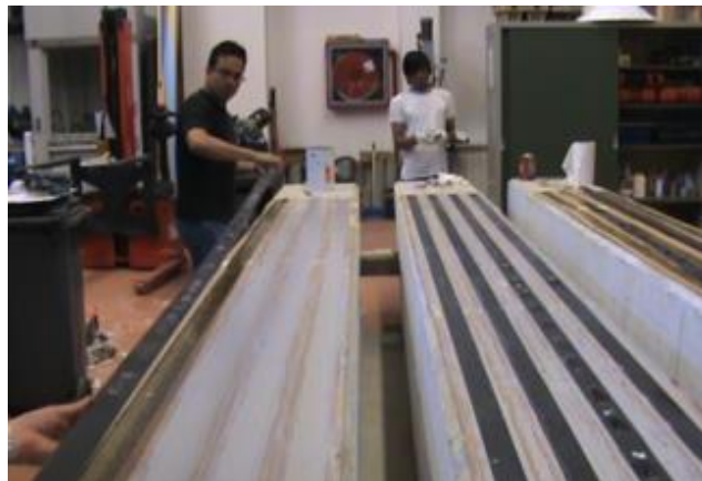
Ilustración 41 Colocación laminados CFRP
