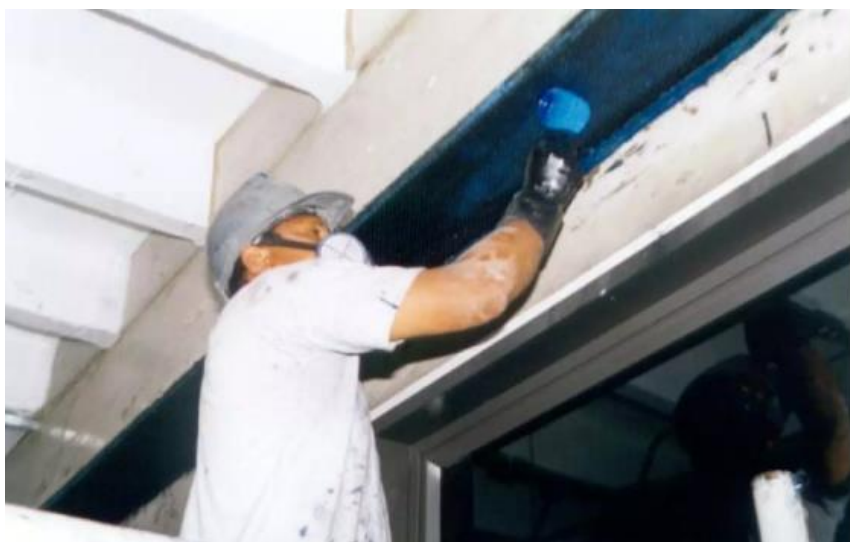
Ilustración 47 Refuerzo a flexión de las columnas de la torre
