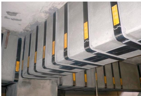
Ilustración 1 Reforzamiento de elemento estructural con fibra de carbono
