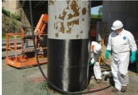
Ilustración 5 Aplicación de CFRP adherido externamente
