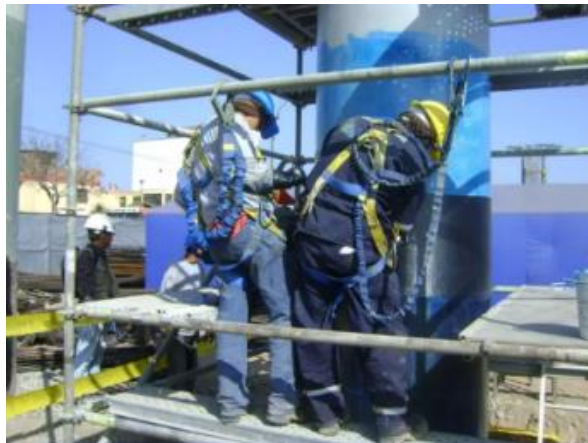
Ilustración 52 Colocación de la fibra con la resina Epoxi
