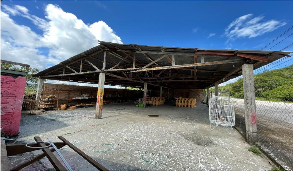
Fotografía 9. Galera de almacenamiento de producto salido del horno y sin pintar
