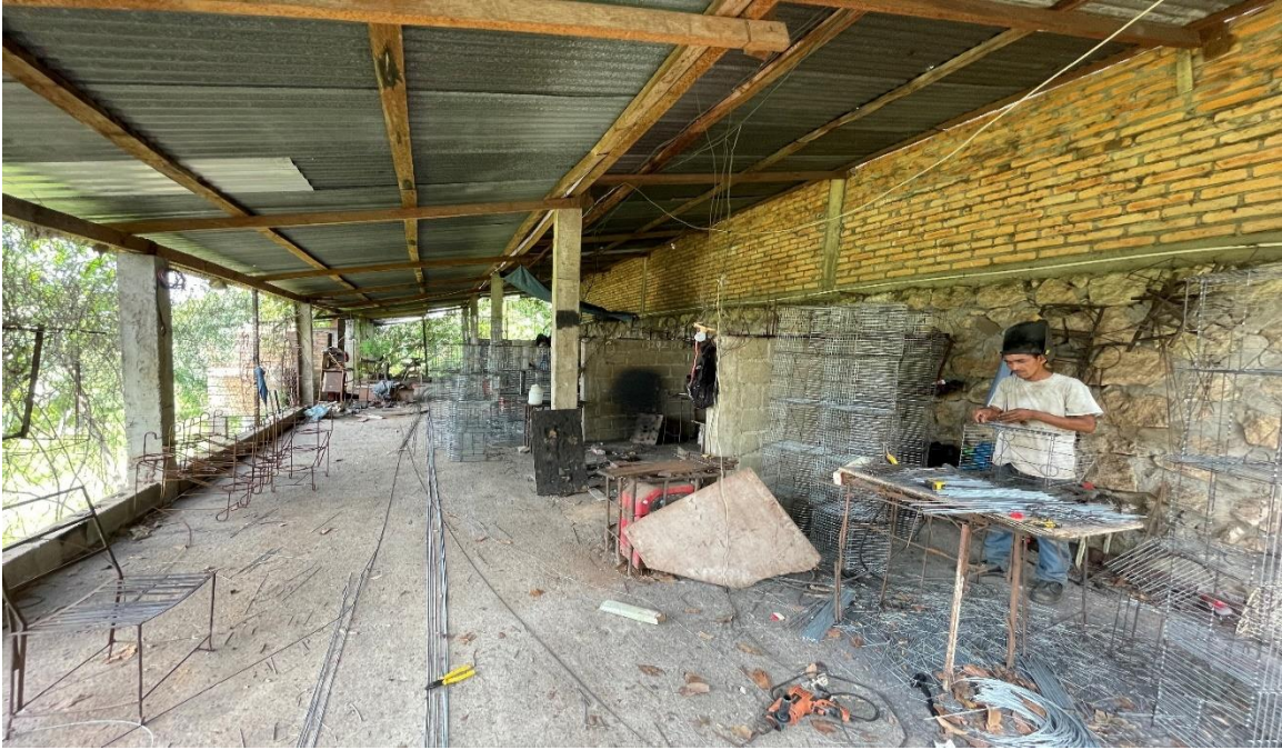
Fotografía 13. Taller de soldadura
