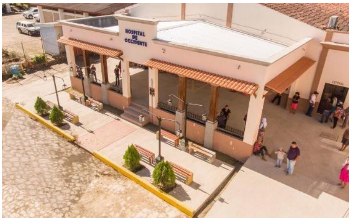
Figura 7. Hospital de Occidente
