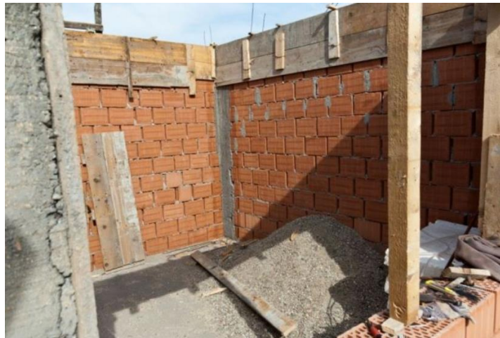
Ilustración 5: Proyecto abandonado por falta de presupuesto
