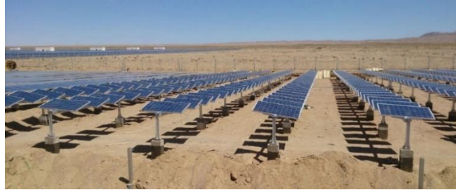
Ilustración 3 – Parque solar Xitianshan ubicado en Dachaidan, China.
