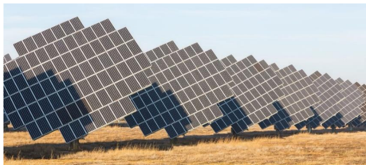
Ilustración 4 – Paneles solares del parque Lasesa III en posición para aprovechar la irradiación solar.
