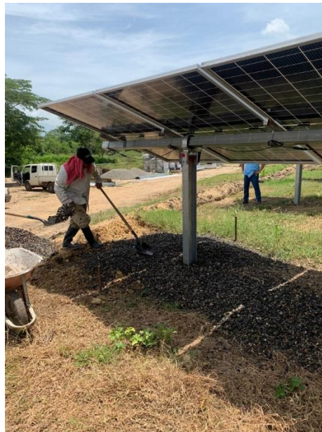
Ilustración 34 – Montaje de la grava.
