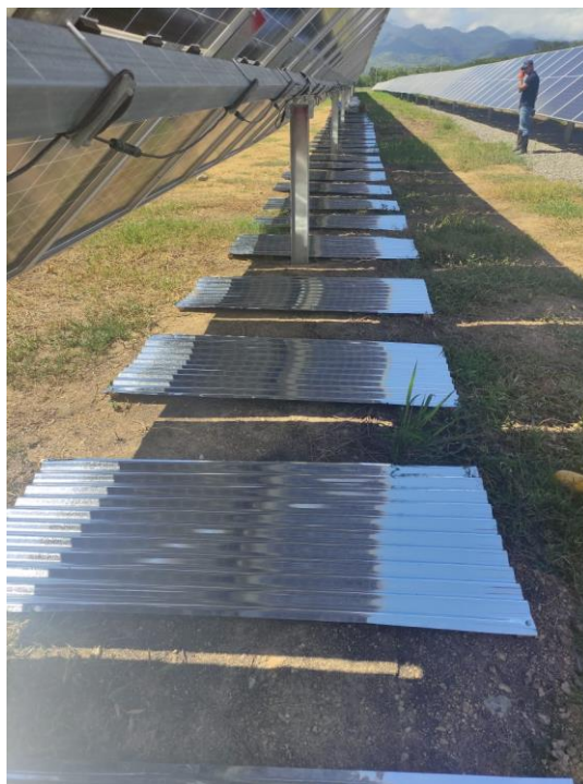
Ilustración 37 – Colocación de las láminas.
