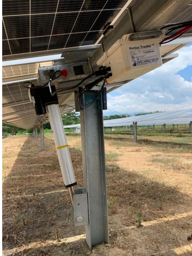
Ilustración 9 - Estructura de la mesa con el equipo de movimiento de las mesas.
