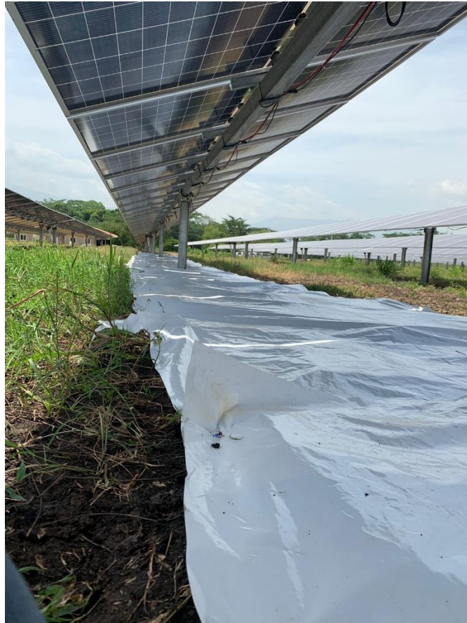
Ilustración 32 – Fijación del nylon en el suelo.
