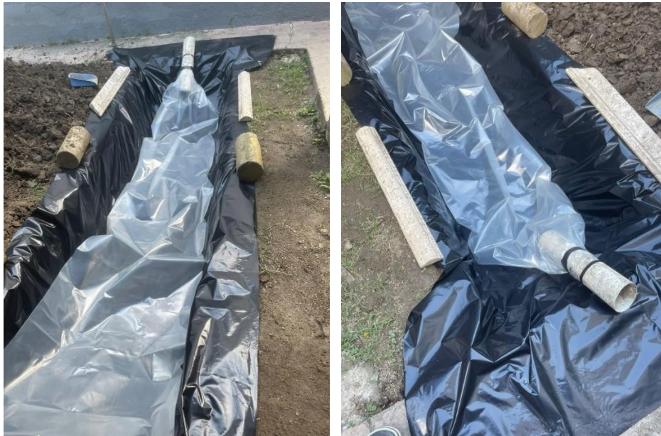
Ilustración 19. Armado e Introducción del Depósito Fuente: Elaboración propia
