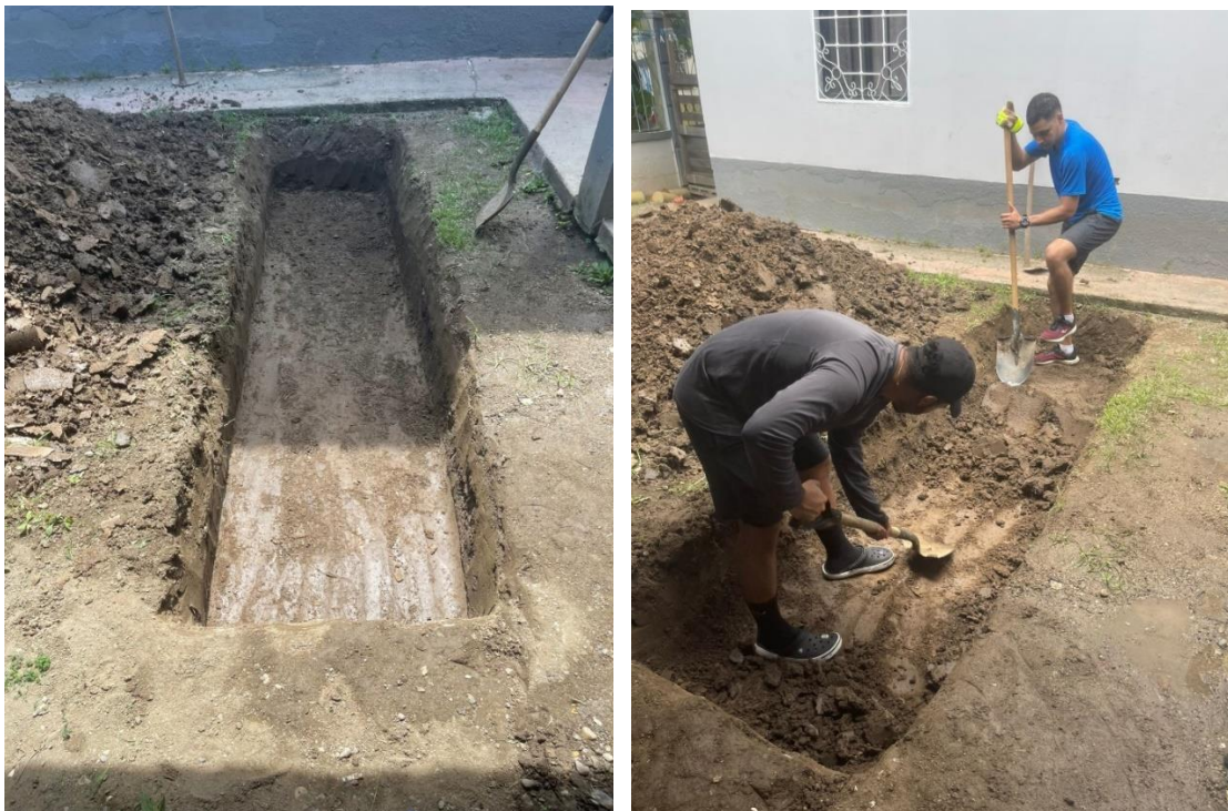
Ilustración 17. Excavación de zanja Fuente: Elaboración propia
