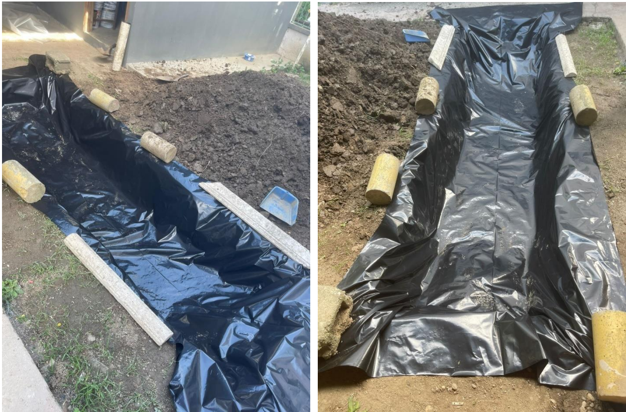
Ilustración 18. Recubrimiento de Zanja Fuente: Elaboración propia
