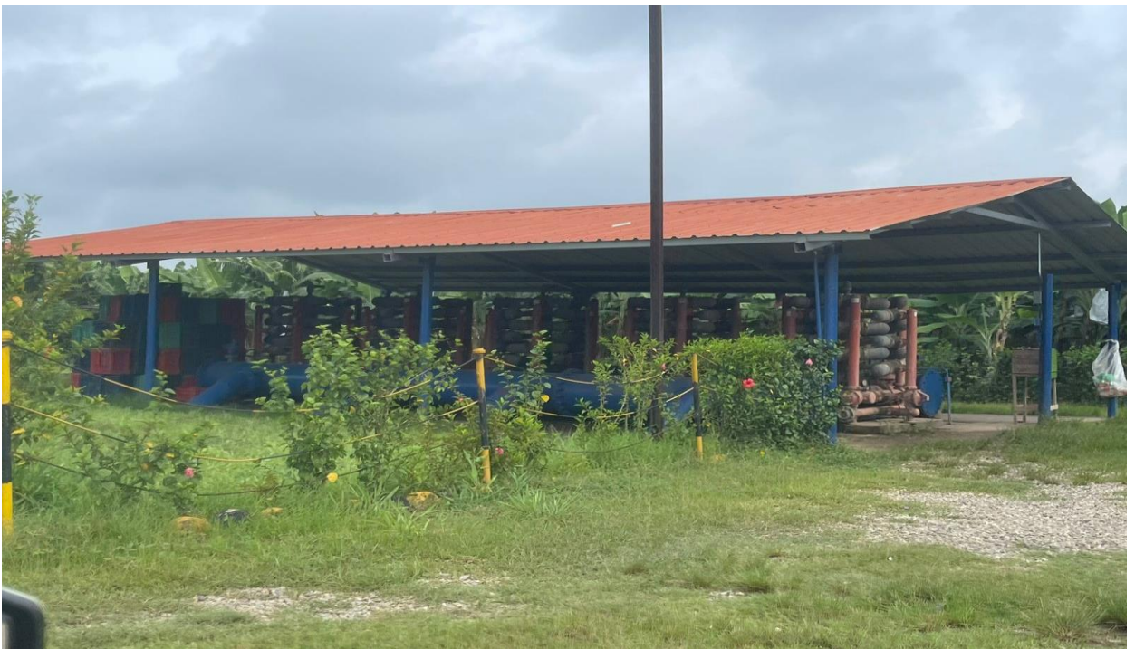
Ilustración 28. Motores de Riego Finca Santa Rosa Fuente: Elaboración propia
