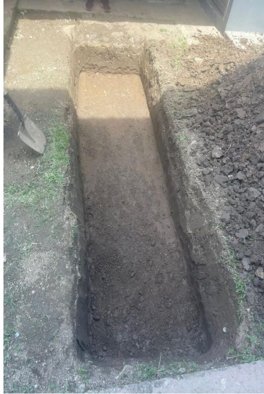
Ilustración 29. Zanja para Instalación de Biodigestor Fuente: Elaboración propia
