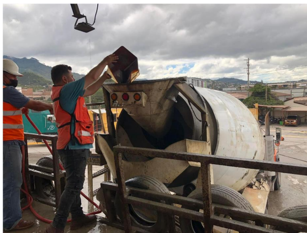
Ilustración 87 - Ajuste de concreto en planta
