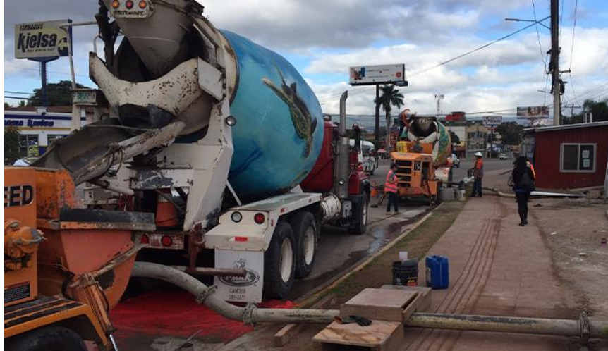
Ilustración 10 - Bombas de concreto estacionario Concremix
