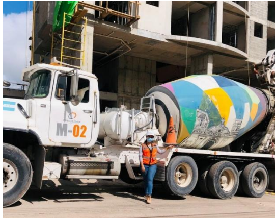
Ilustración 79 - Visita al proyecto Torre Ámbar
