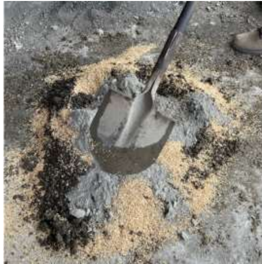
Ilustración 23 Mezcla con igual cantidad de cáscara de arroz y cemento
