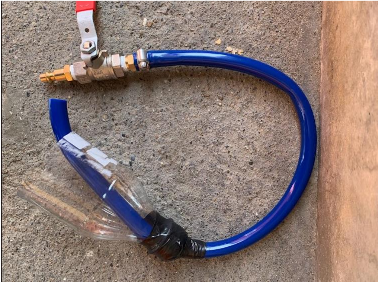
Ilustración 25 Sistema de conducción de biogás
