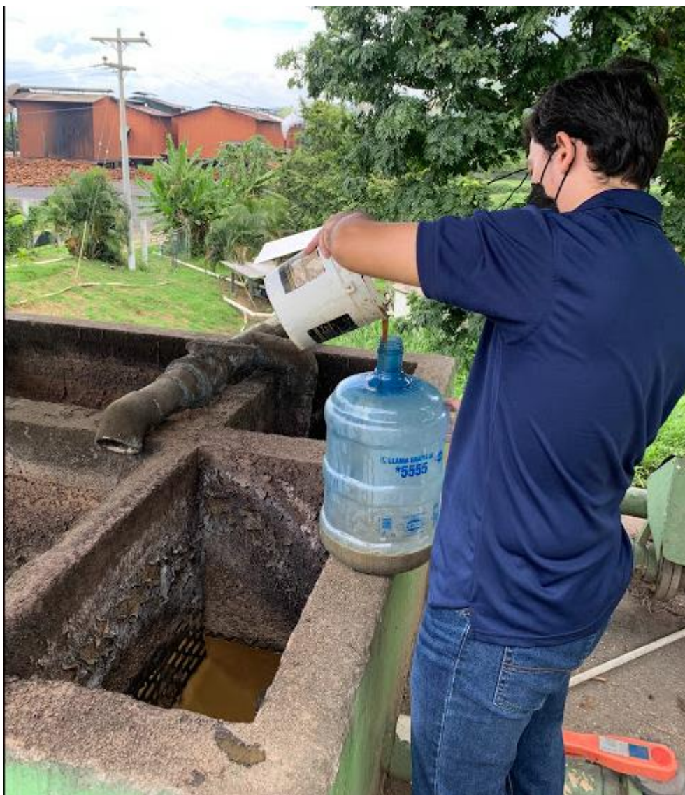
Ilustración 33 Vertimiento de POME sin digerir en compartimiento para biodigestor
