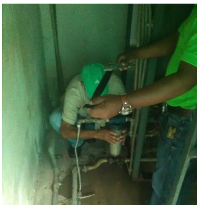
Ilustración 37. Cambio de filtro en autoclave
