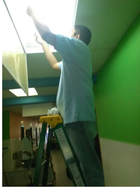
Ilustración 53. Lámpara en mal estado
