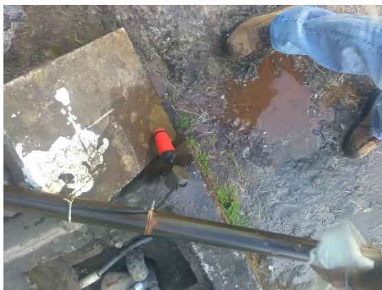
Ilustración 55. Limpieza de filtros en cisterna
