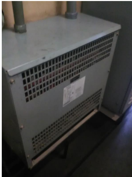
Ilustracion 10. Transformador
