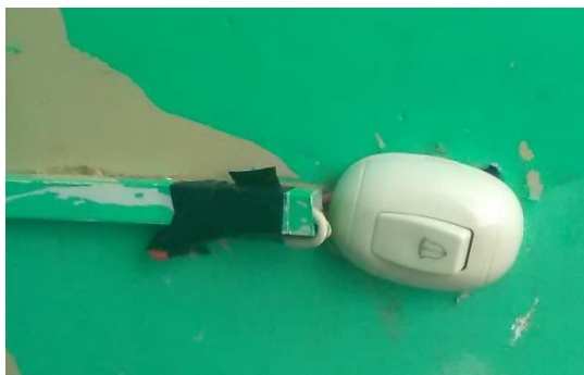
Ilustración 49. Instalación de interruptor de timbre
