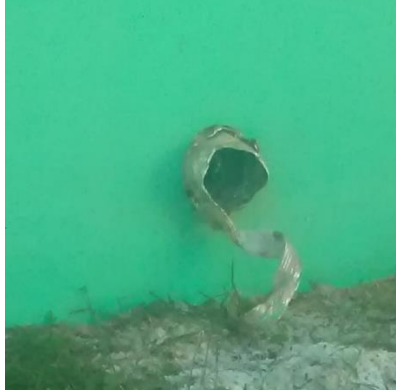
Ilustracion 29. Tuberia para sacar calor
