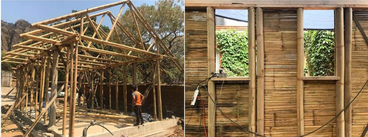
**Ilustración 4. Detalle del bambú en estructuras y cerramientos**
