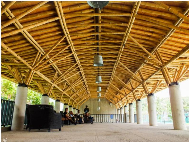
**Ilustración 45. Bambú utilizado en cubiertas**
