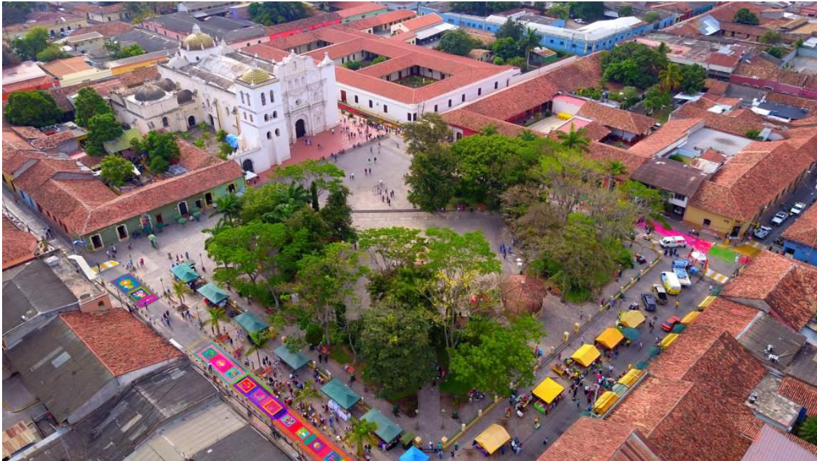
Ilustración 49. Vista aérea del centro histórico de Comayagua, Comayagua.
