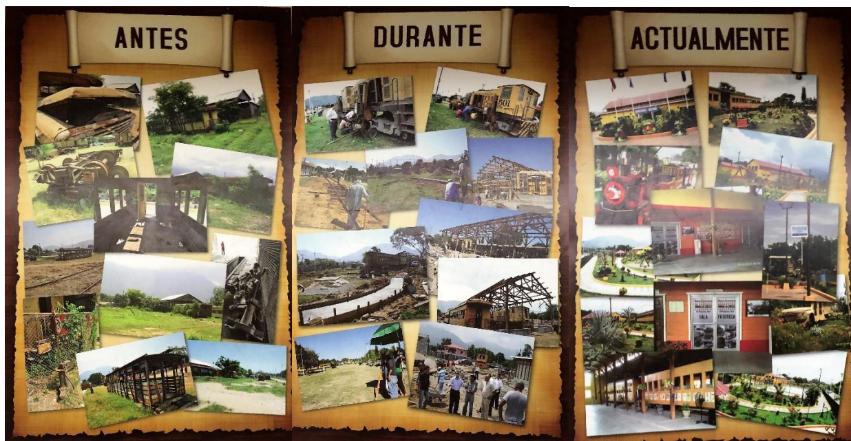
Ilustración 40. Proceso de Ejecución del Museo Ferroviario
