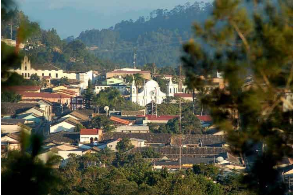
Ilustración 47. Vista aérea del centro histórico de Santa Rosa de Copán.
