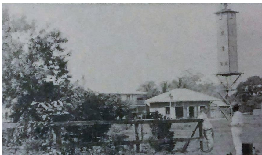
Ilustración 13. Instalación del reloj, 1925
