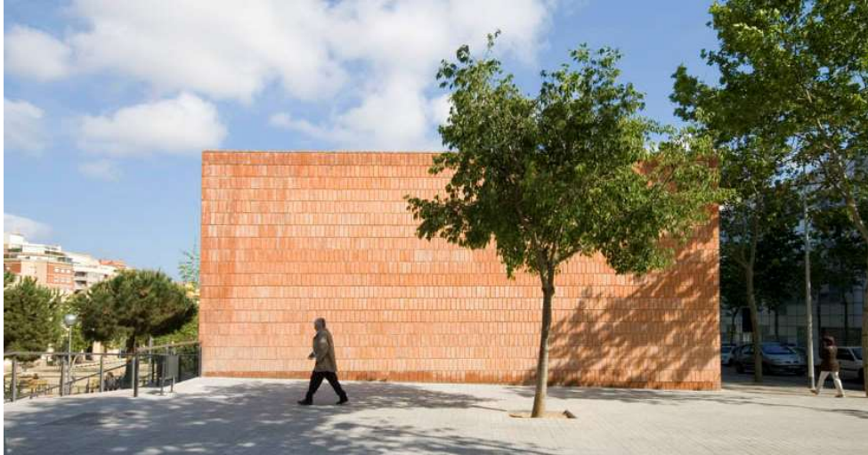
Ilustración 31: Fachada Sureste Casa Para La Tercera Edad
