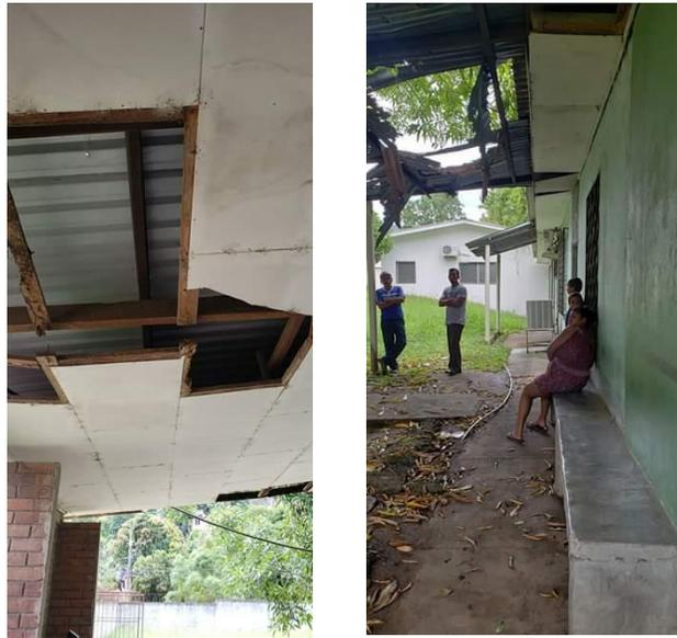
**Ilustración 18. Condiciones del techo en mal estado en el centro de salud José Inés.**
