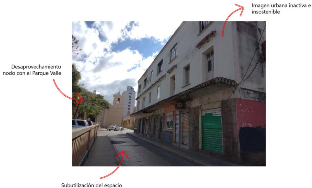
Ilustración 14. Edificación en abandono Ave. Miguel Paz Barahona.
