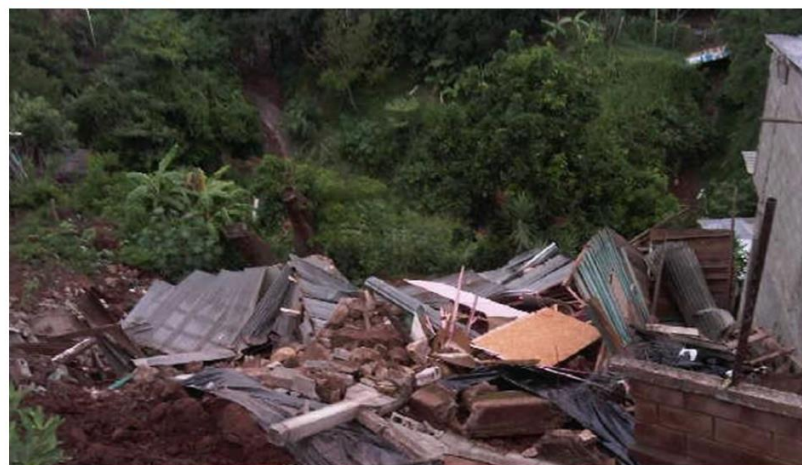
Ilustración 2 Noticia recolectada del Diario La Prensa sobre pérdidas de viviendas a causa de deslizamientos en Tegucigalpa. ( https://www.laprensa.hn/honduras/tegucigalpa/333336-98/deslizamiento-de-tierra-causa-derrumbe-de-vivienda-en-tegucigalpa , s.f.)
