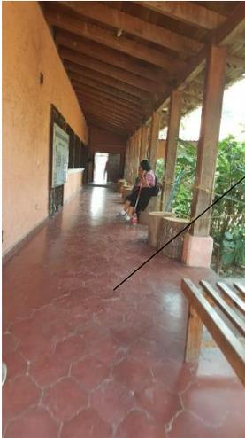
Los pasillos de circulación interior no tienen una franja de diferente textura de piso que guíe al usuario, se encuentra un poco deteriorado el piso y con manchas.
