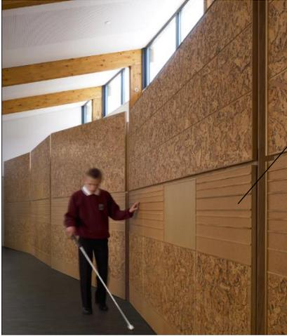
Separaciones movibles de fibra de madera con diferentes texturas, se puede observar que a un nivel de 0.90 metros del suelo se encuentra una franja horizontal la cual lleva la misma dirección que el pasillo por medio de esto el ciego se guía para llegar a su destino.
