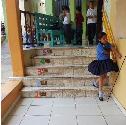
A pesar de ser las escaleras de una escuela especial para ciegos no existe una franja de prevención con diferente textura al inicio y al final de las gradas, también se puede observar en la ilustración 14 la incorrecta colocación de mobiliario en el pasillo de circulación lo que causa que la persona ciega se tropiece.
