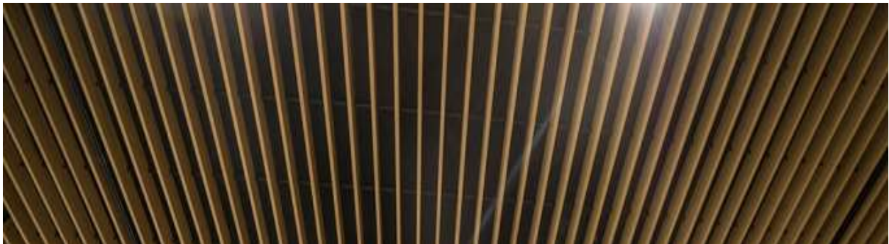
Ilustración 16. Paneles de Madera
