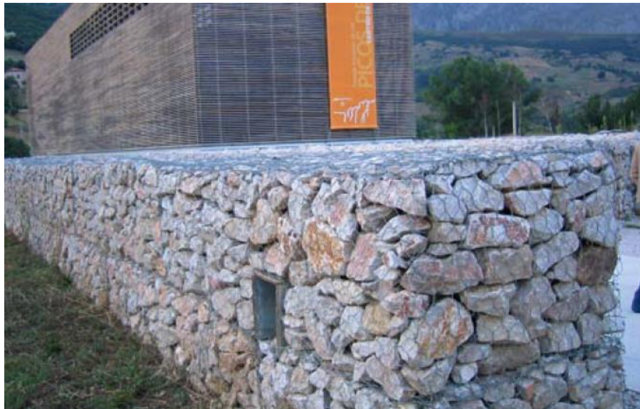
Ilustración 74: Muro de Gavión con piedra de 3/4
