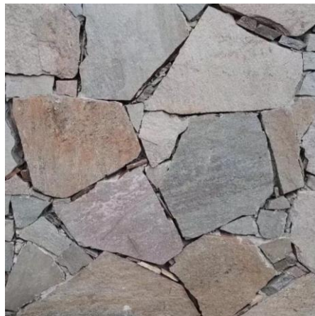
Ilustración 71: Mampostería de piedra de laja.
