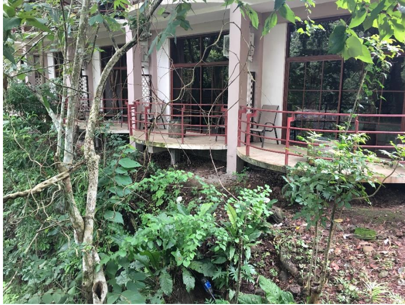
Ilustración 57: Terraceo de habitaciones, Cascata Lodge.
