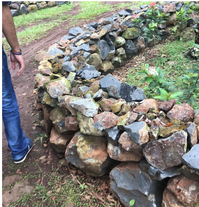
Ilustración 56: Muro guía, Cascata Lodge.
