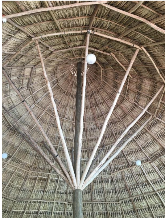
Ilustración 100: Estructura de madera en Bar, Cascata Lodge
