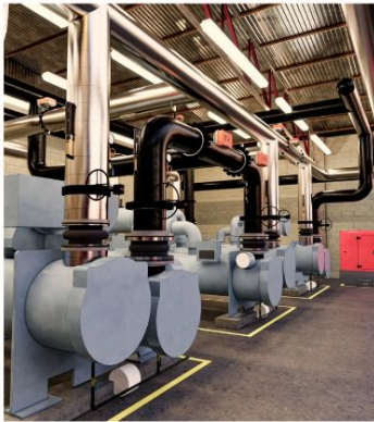
Figura 40. Instalaciones Gildan Rio Nance
