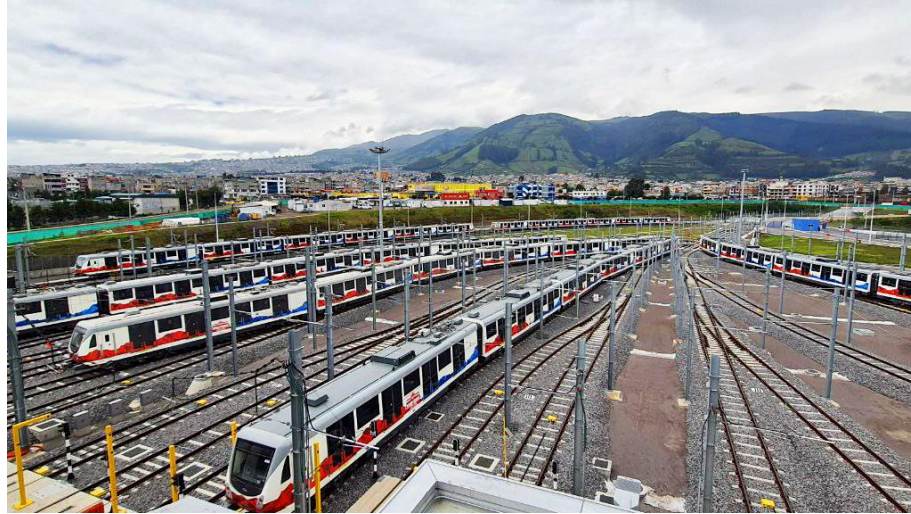
Figura 31. Obras en el metro de Quito Fuente: (Urban Transport Magazine, s.f.)
