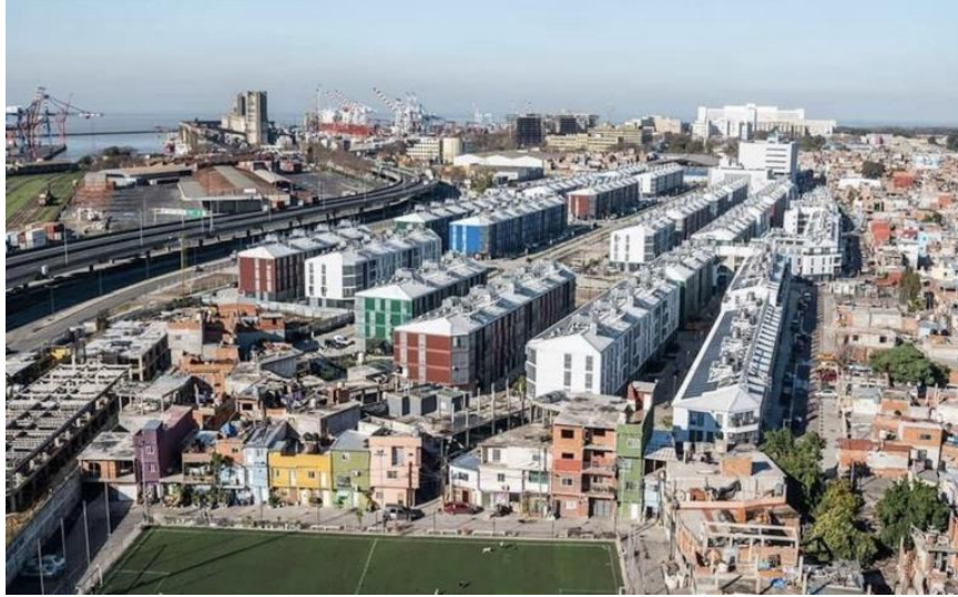
Figura 30. Obras de mejoramiento en el Barrio Carlos Mujica 31
