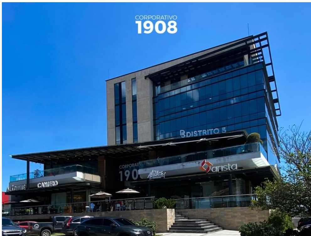
Ilustración 5 Edificio Corporativo 1908, Oficina Celsia, San Pedro Sula
