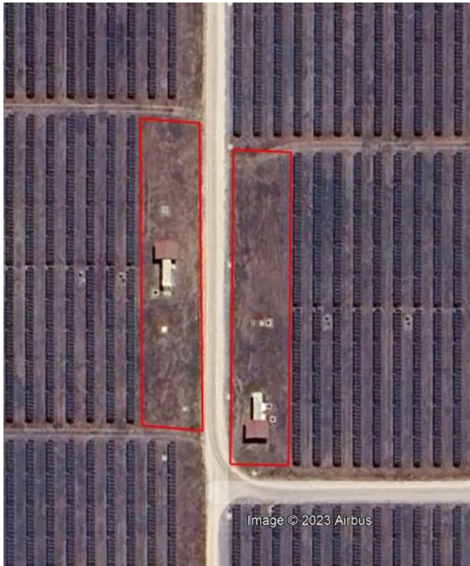
Figura 18. Área Típica de Ubicación de Transformadores.
