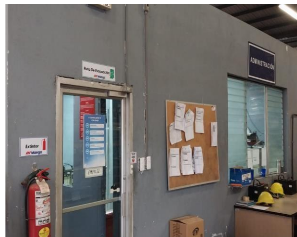
Figura VIII.8 Señalización de ubicación de extintores
