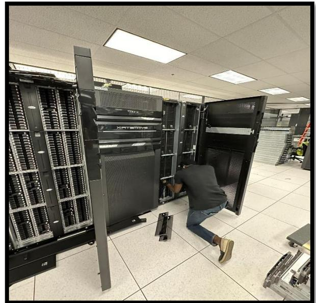
*Ilustración 26 desmontaje de rack*
