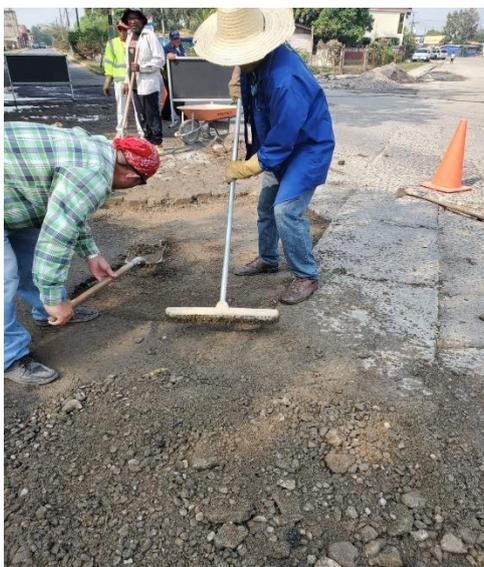
**Ilustración 29-Reparaciones en la Capa de Rodadura**
