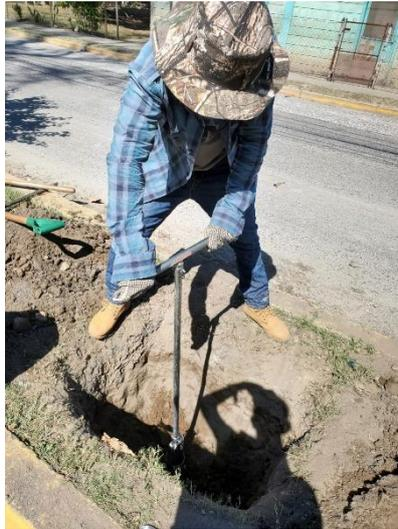
**Ilustración 105- Extracción de terreno natural con barreno.**
