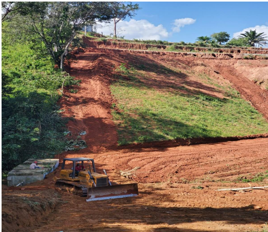
Ilustración 26-Cortes en Terreno
