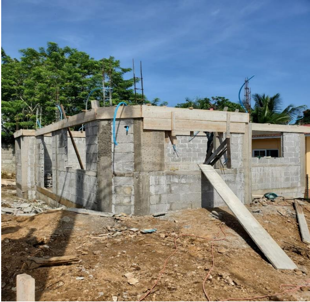
Ilustración 7-Fundición Solera Superior
