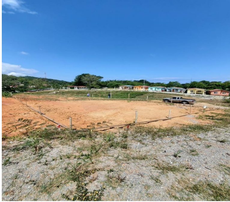
Ilustración 3-Trazado y Marcado
