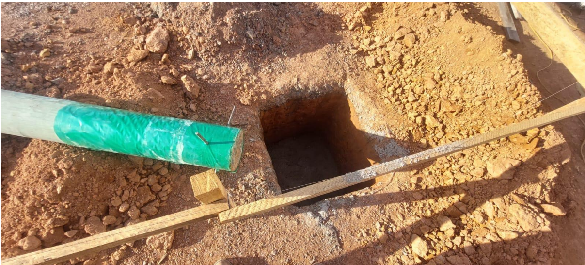
Ilustración 28-Cimentación de Chalet
