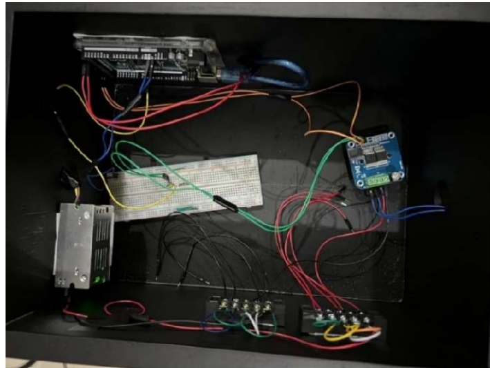
Ilustración 66. Proceso de montaje sistema electrónico.
