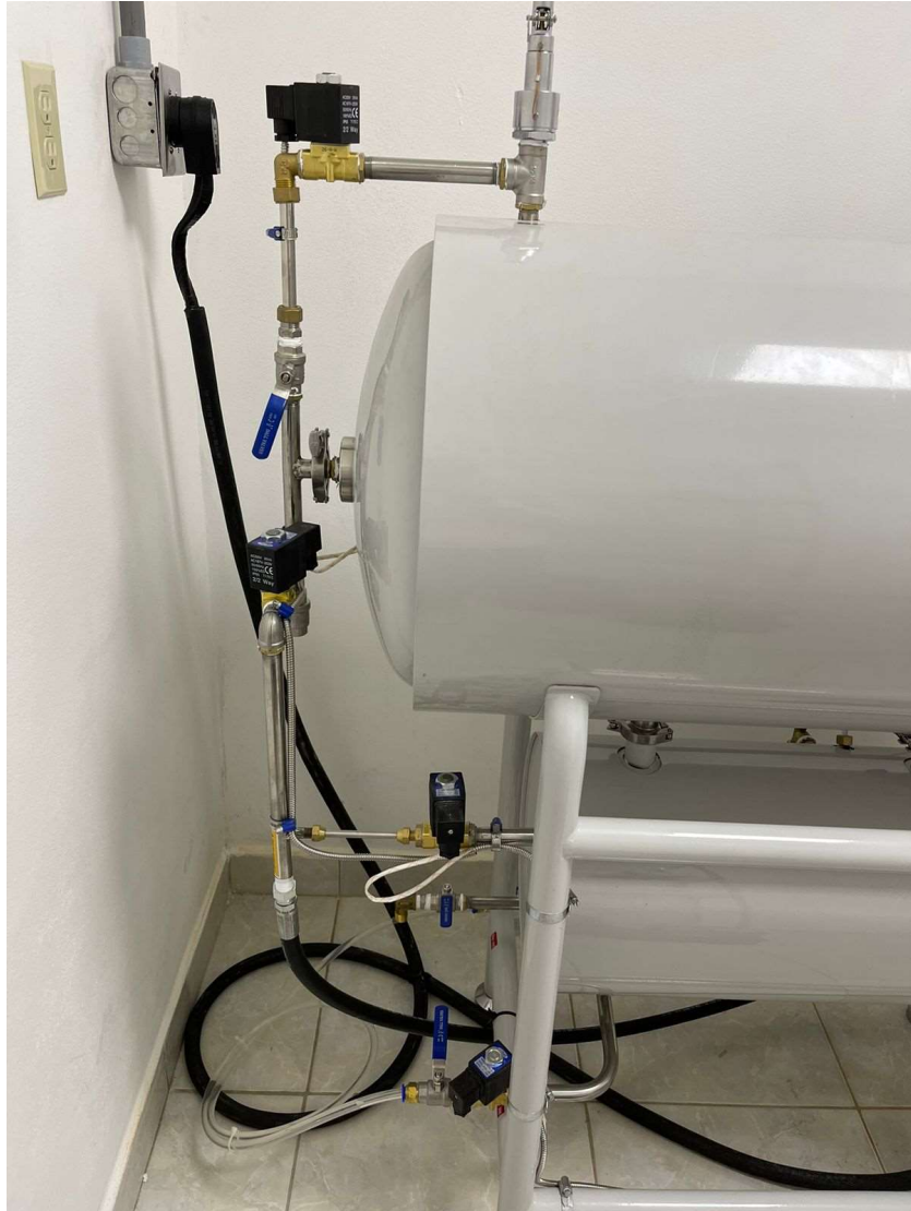
Ilustración 29. Conexión de mangueras para entrada y salida de agua en autoclave. Fuente: Elaboración Propia.
