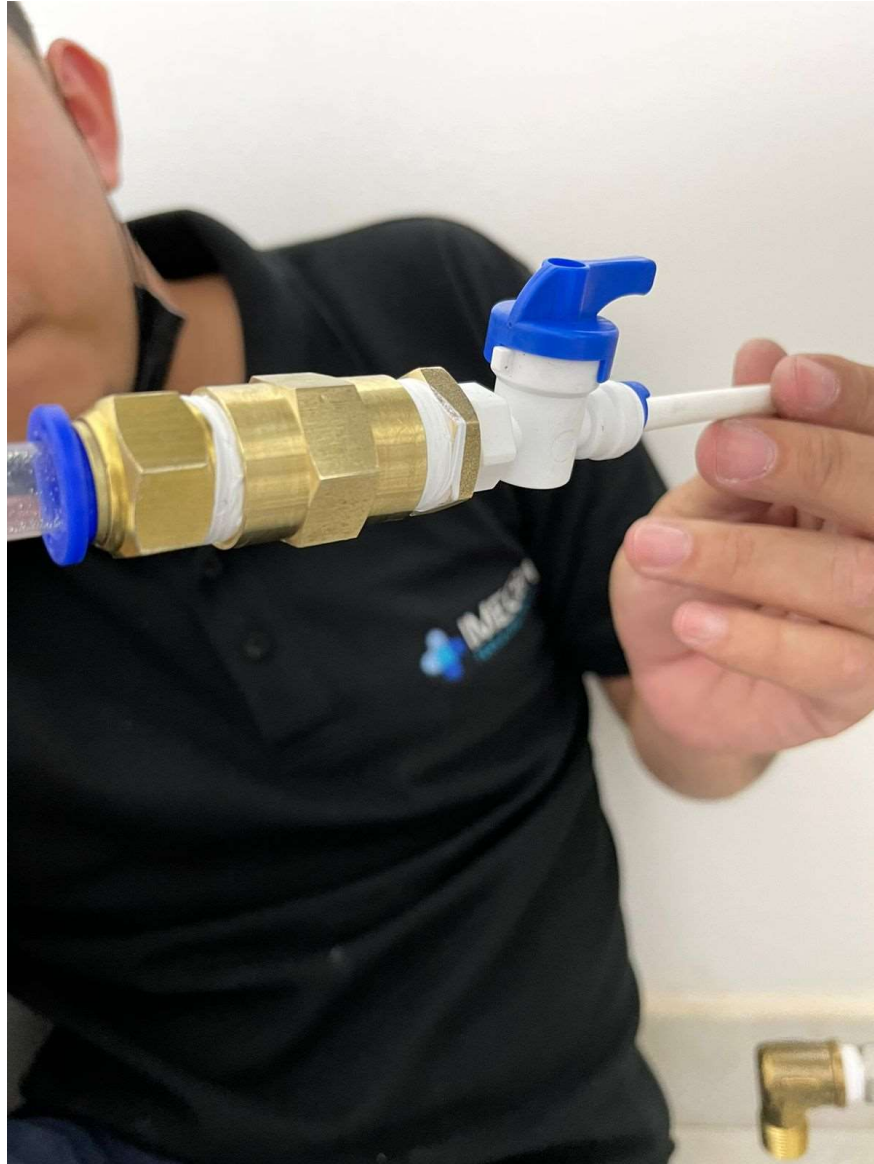
Ilustración 31. Revisión de fugas de agua en conexiones de autoclave.
