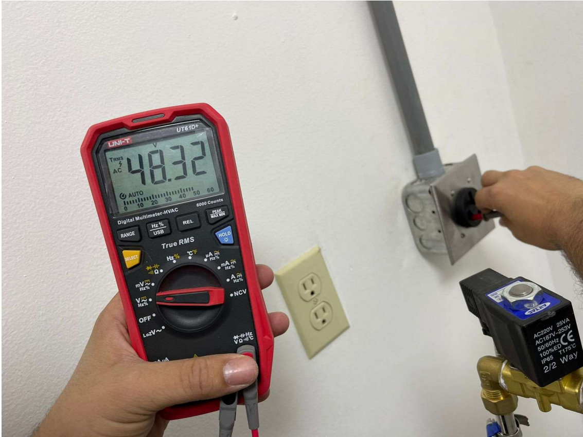
Ilustración 30. Verificación de red eléctrica con multímetro para conexión de autoclave. Fuente: Elaboración Propia.
