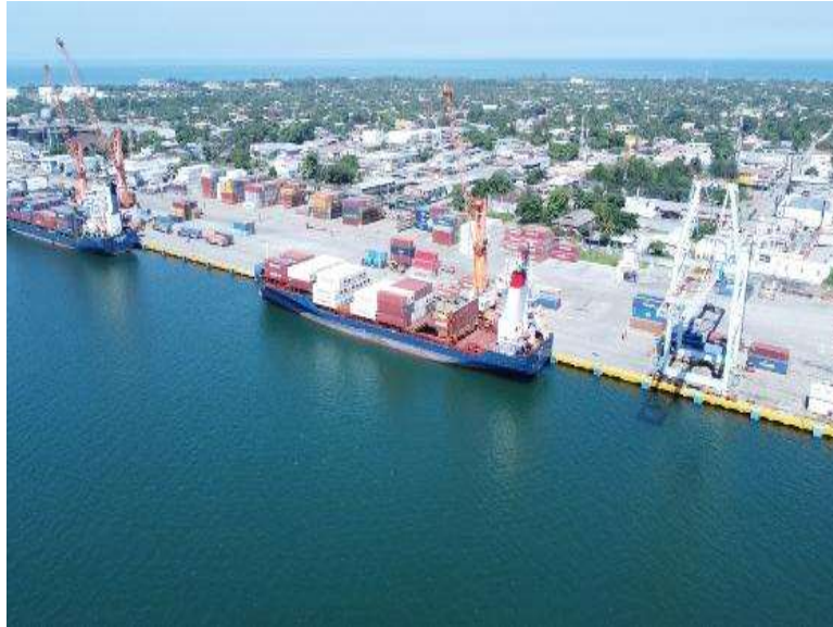
Figura 13. Terminal Contenedores en Puerto Cortés
