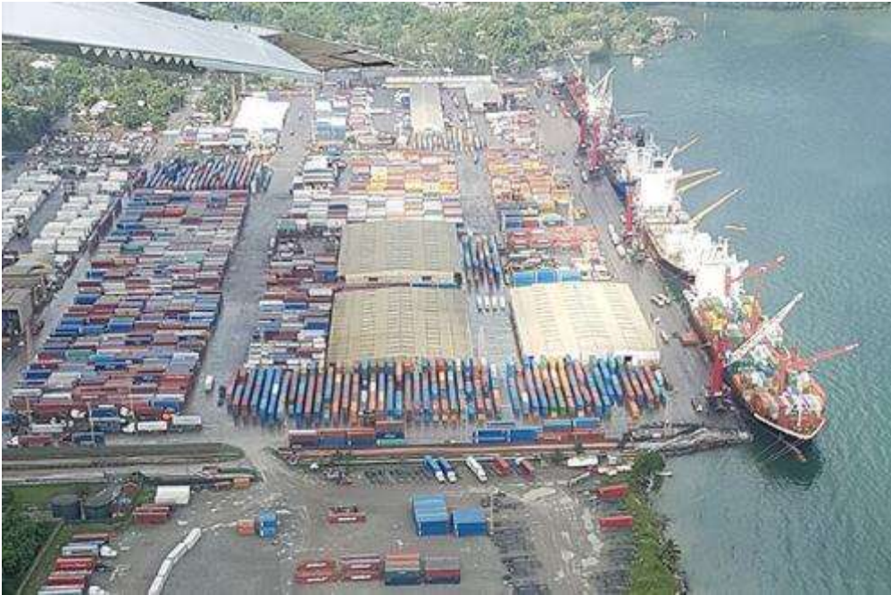
Figura 16. Terminal de Santo Tomas de Castilla, Guatemala. Fuente (Empresa Portuaria Nacional, 2021)
