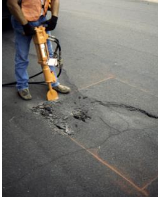
Ilustración 24 - Marcaje y excavación
