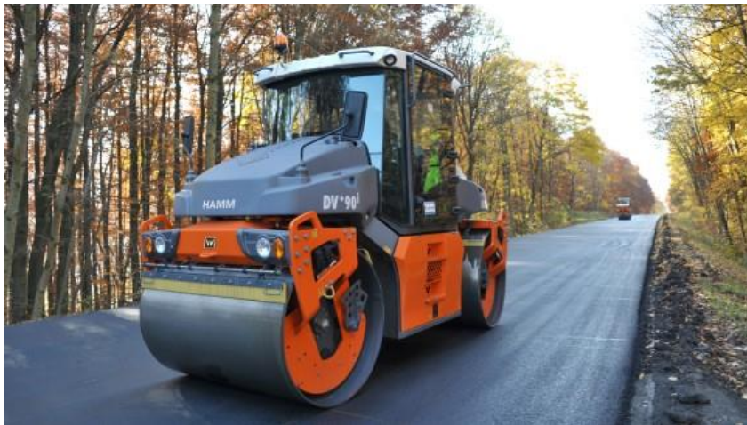
Ilustración 28 - Compactación capa asfáltica
