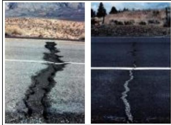
Ilustración 12 - Fisura transversal
