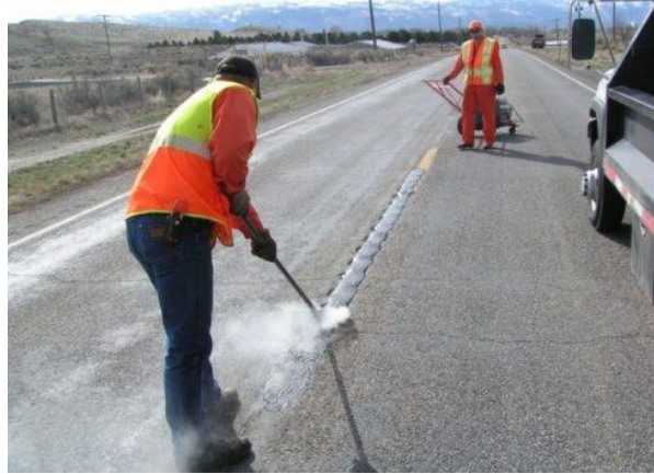
Ilustración 21 - Procedimiento sellado de grietas
