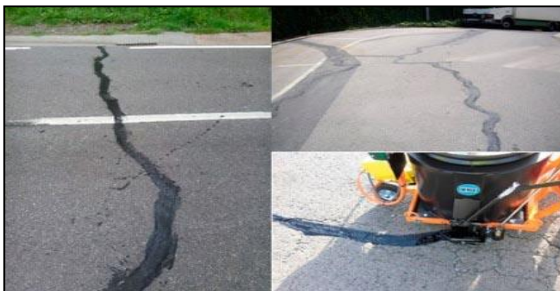
Ilustración 29 - Sello de fisuras
