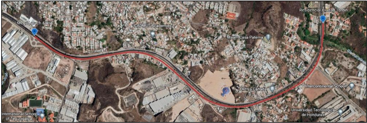
Ilustración 3-Tramo Anillo Periférico Mega Larach Periférico - Residencial Ciudad Jardín
