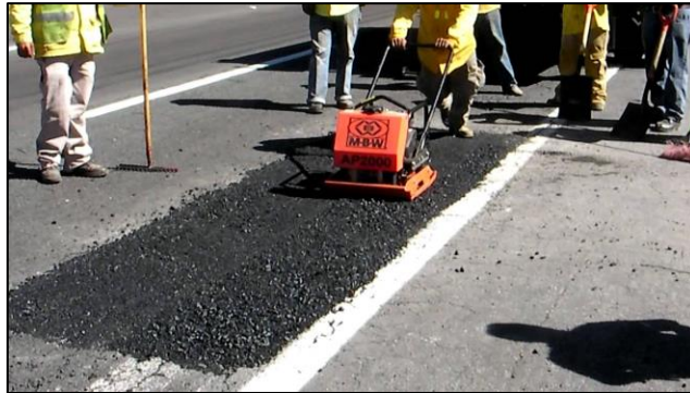
Ilustración 23 - Reparación de áreas de falla (Bacheo profundo)
