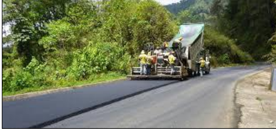
Ilustración 27 - Colocación de capa asfáltica
