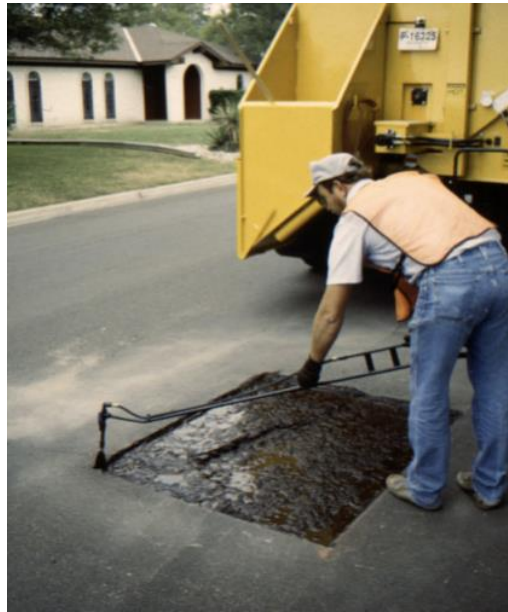
Ilustración 25 - Colocación mezcla asfáltica
