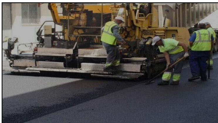
Ilustración 30 - Colocación de capa asfáltica de refuerzo
