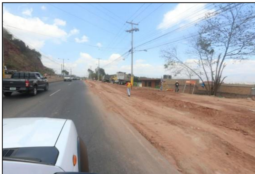
Ilustración 32 - Adición tercer carril
