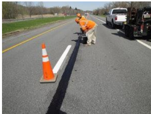
Ilustración 22 - Sellado de grietas
