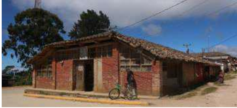
Ilustración 17. Mercado Municipal construido con ladrillos y tejas en Santa Elena, La Paz
