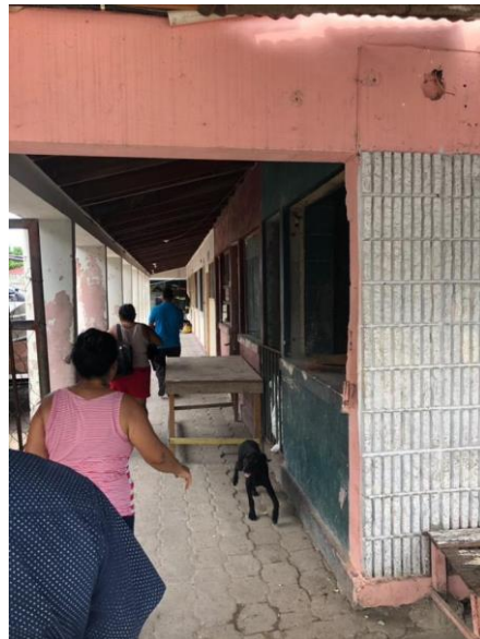
Ilustración 35. Locales comerciales mercado municipal
