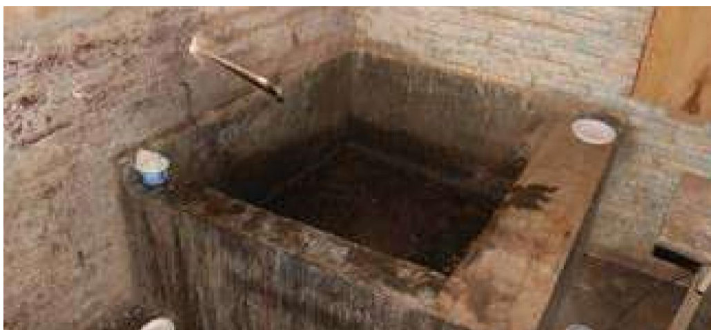
Ilustración 23. Área de aseo
