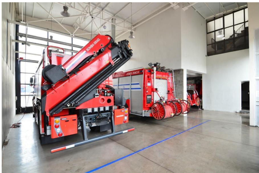
Ilustración 97. Iluminación desde el cuarto de máquinas
