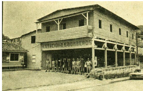
Ilustración 8. Primer Cuartel de Bomberos Tegucigalpa, M.D.C
