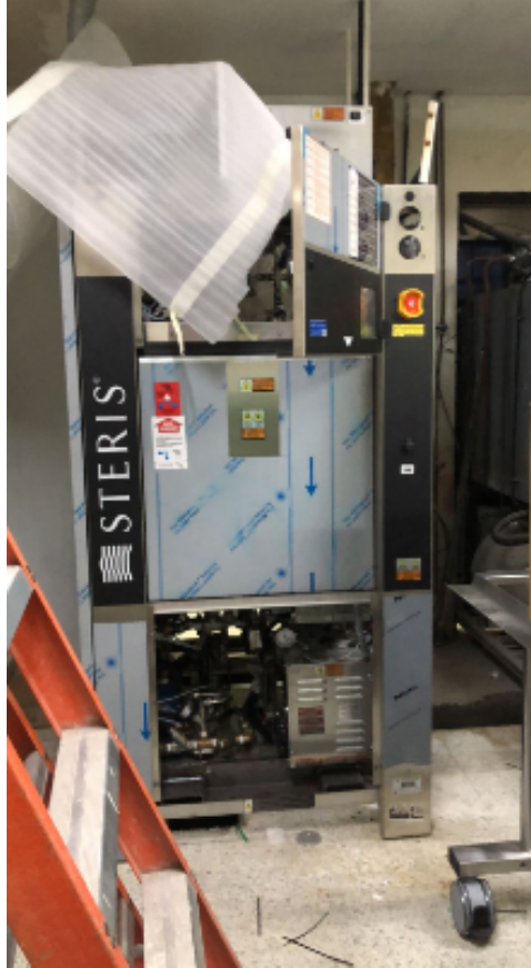
Ilustración 39 - Instalación autoclave
