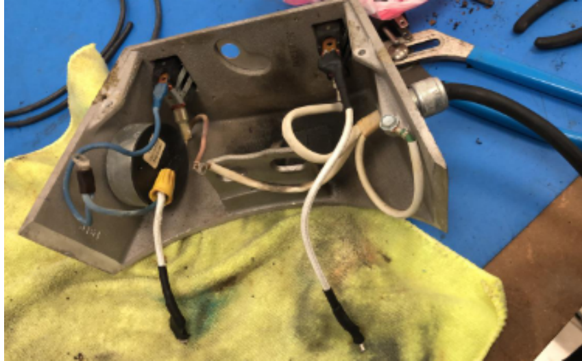
Ilustración 56 - Cambio de cables
