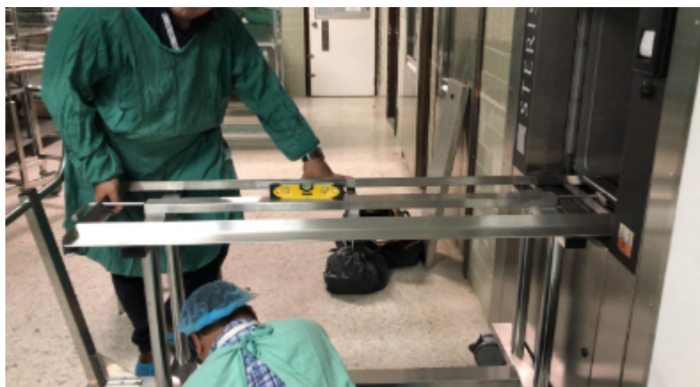
Ilustración 46 - Alineación de carro de descarga
