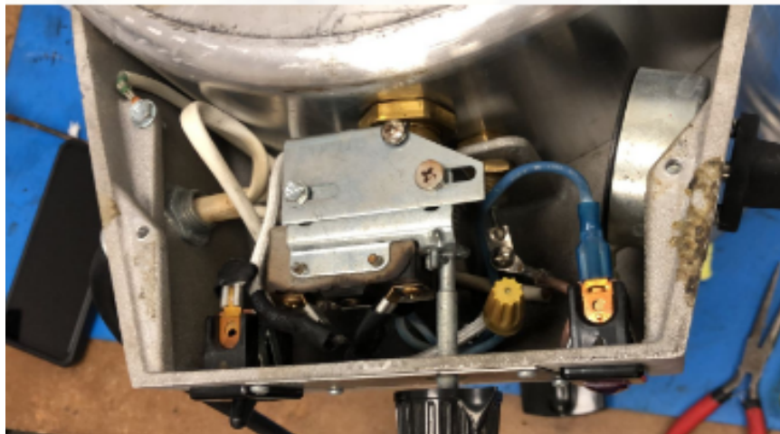
Ilustración 57 - Cambio de cables
