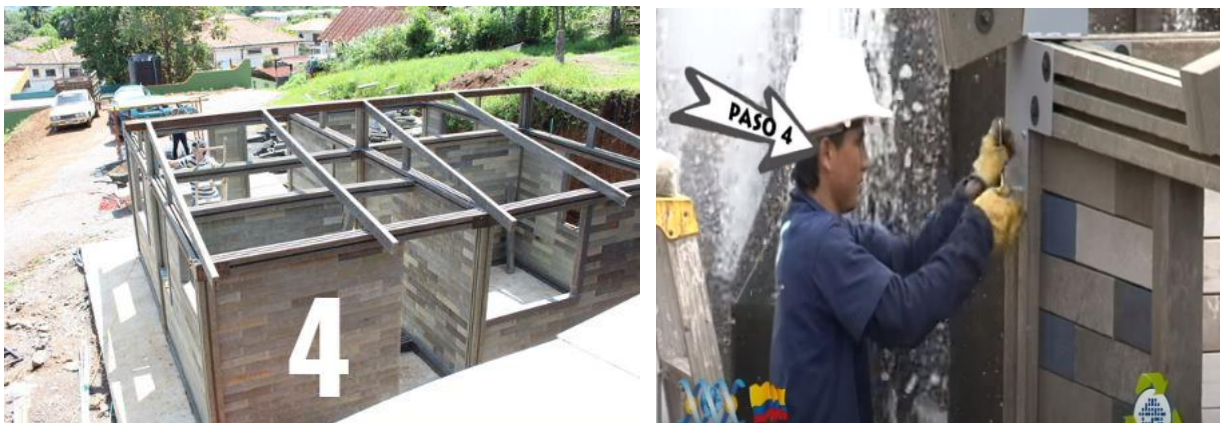
Ilustración 71. Proceso de instalación de cubierta
