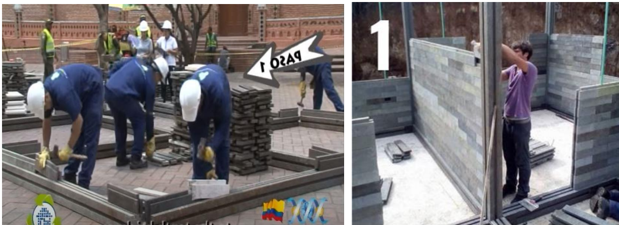
Ilustración 68. Levantamiento de muros hasta las 10ma hilada
