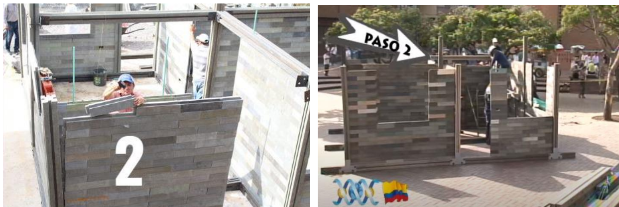
Ilustración 69. Levantamiento de muros hasta el remate
