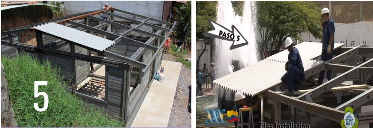
Ilustración 72. Proceso de instalación de lamina
