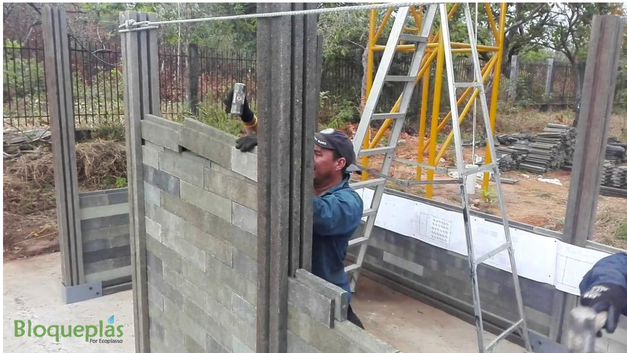
Ilustración 65. Proceso de construcción con Bloqueplás
