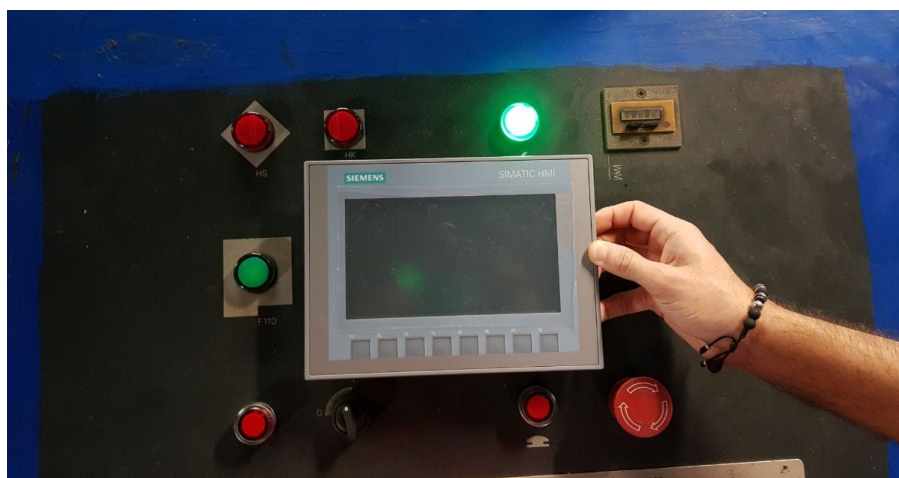
Ilustración 36 - Instalación de KTP 700 en Panel Principal
