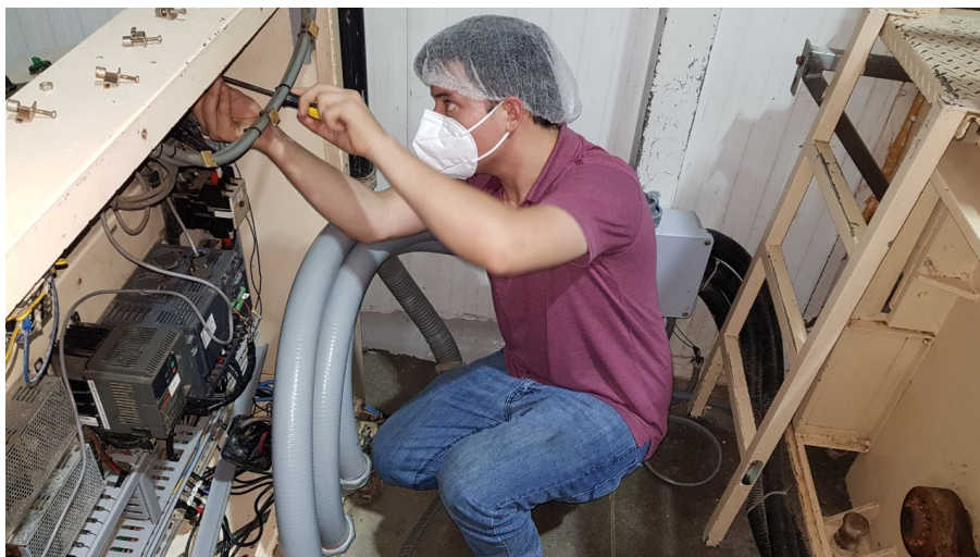
Ilustración 39 - Desmontaje de PLC
