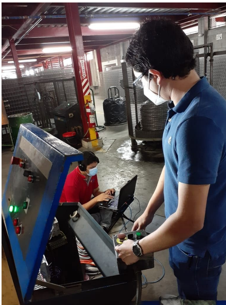
Ilustración 34 - Pruebas de Panel Principal y Remoto
