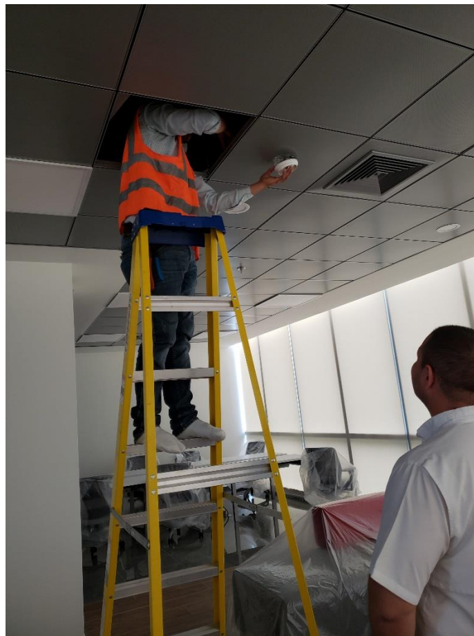
Ilustración 19: Técnico revisando los sensores de Humo
