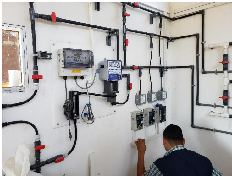
Ilustración 15: Modulo Precloracion
