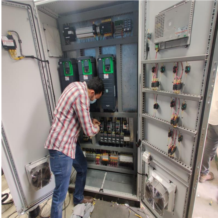
Ilustración 26-Montaje final del panel de control
