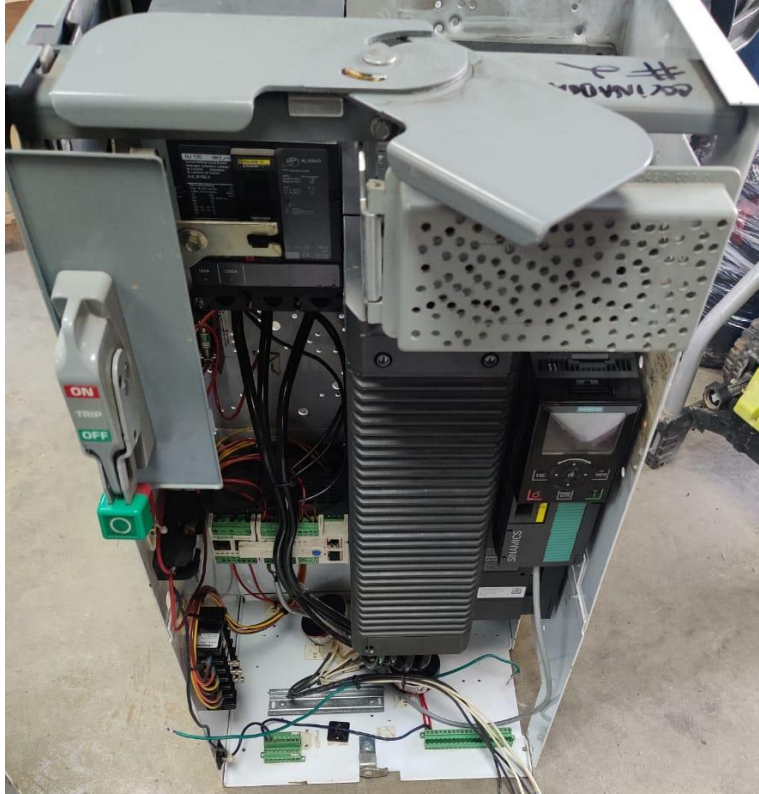
Ilustración 17-Montaje de panel industrial
