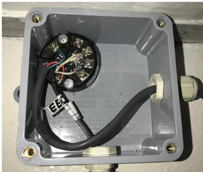
Fuente: Ilustración 24. Instalación de Termocupa y su respectivo convertidor
