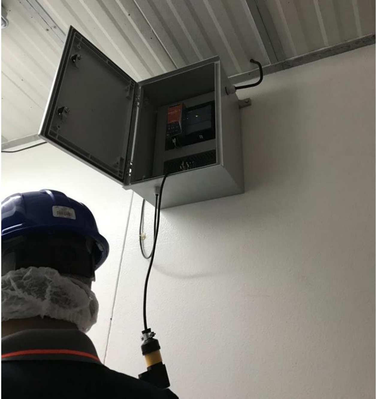
Ilustración 28. Vista ampliada de la instalación del gabinete de control
