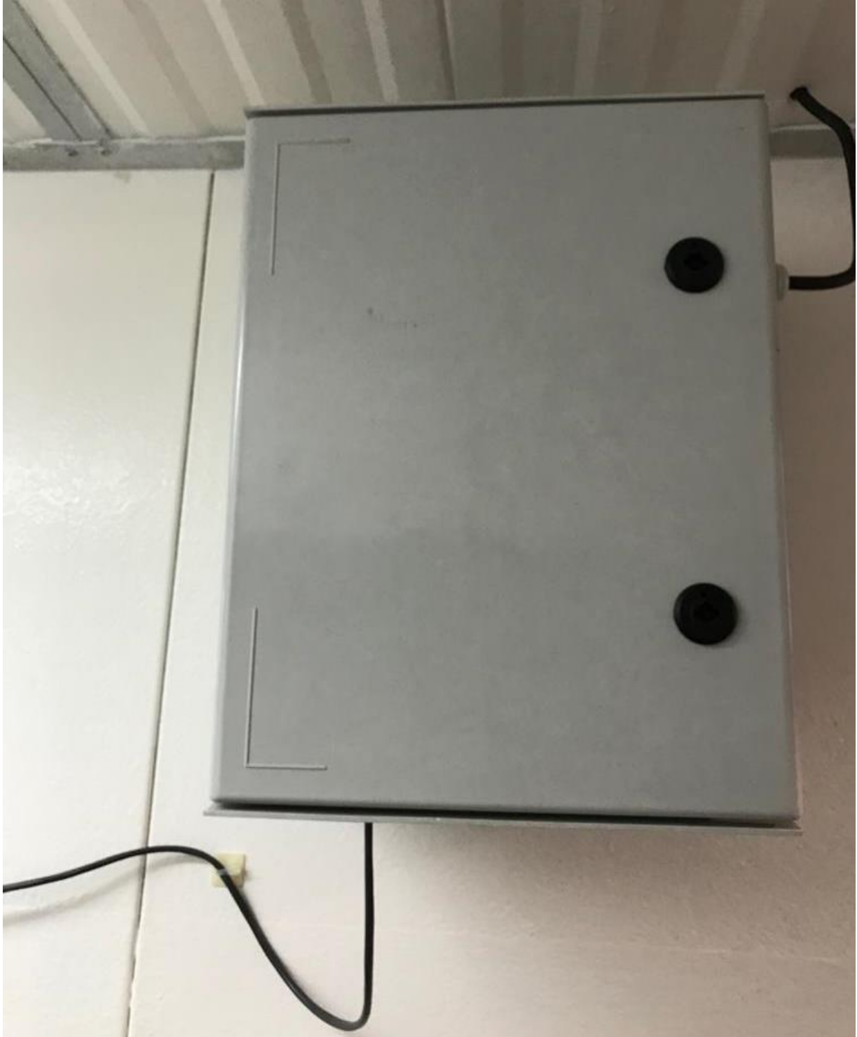
Ilustración 27. Instalación de gabinete de control
