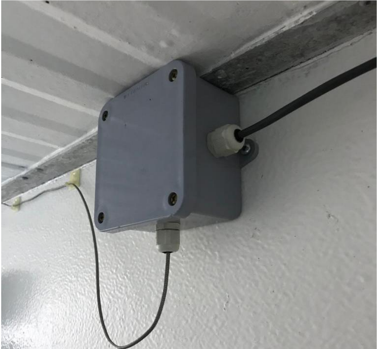
Ilustración 26. Instalación de caja Cantex-Termocupla
