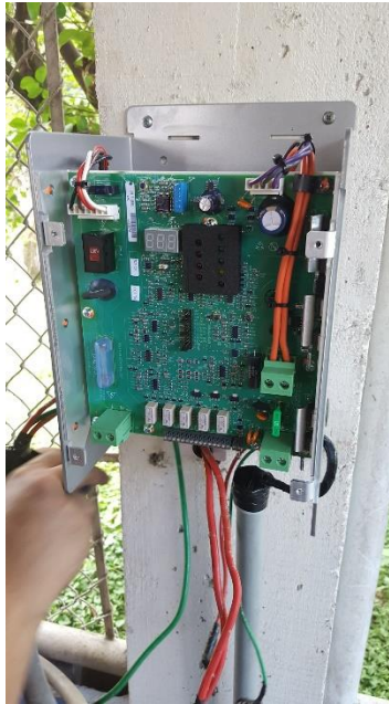
Ilustración 22. Instalación de cargador de baterías.
