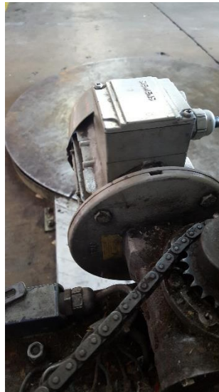
Ilustración 23. Cambio de caja reductora
