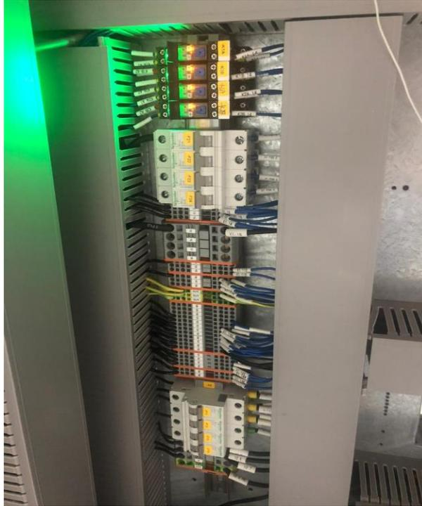
**Ilustración 12-Relés, banco de breaks y borneras del panel de control**
