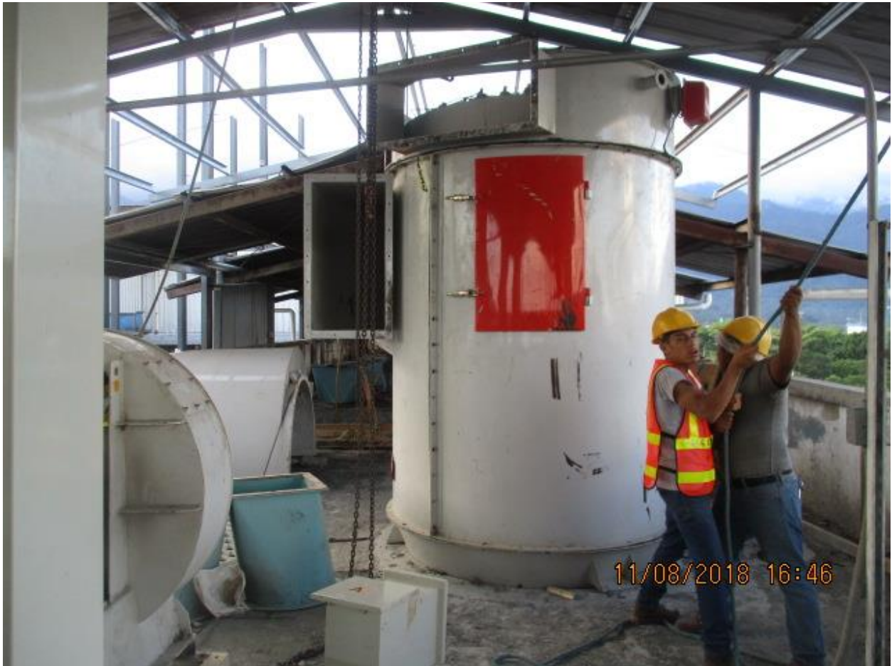
Ilustración 16 - Filtro de aspiración de polvos
