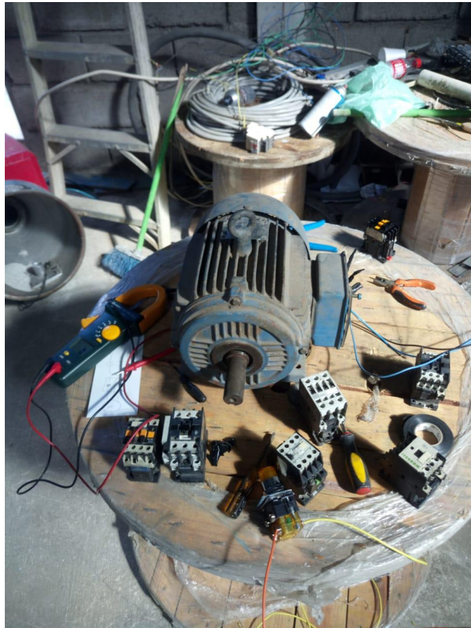
Ilustración 22. Pruebas en equipos de protección
