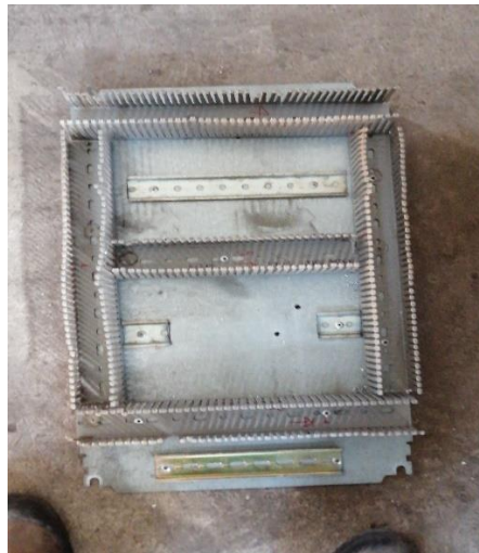
Ilustración 12. Instalación de rieles DIN y canaletas de distribución
