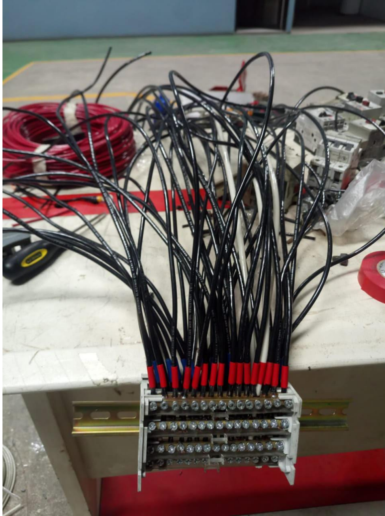
Ilustración 24. líneas utilizadas para cableado de componentes
