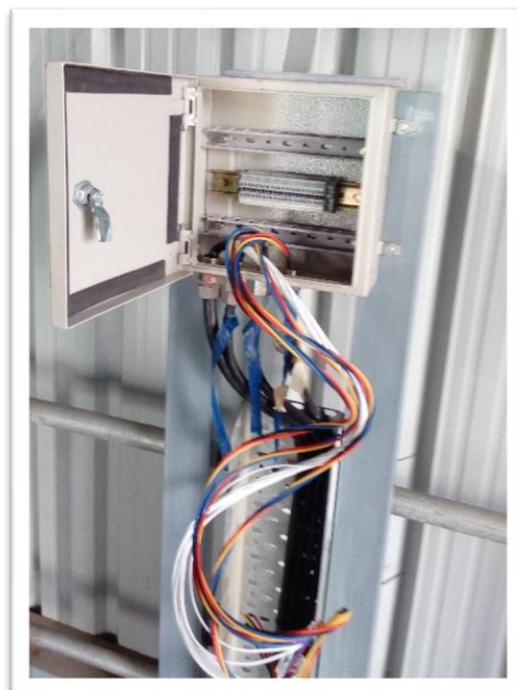
**Ilustración 27. Prueba de señales en cajas de conexiones**
