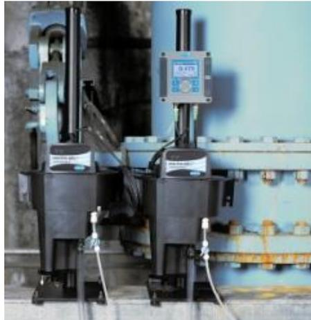
**Ilustración 14. Analizador de turbidez HACH**
