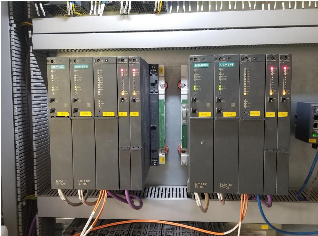
**Ilustración 30. PLCs ya en línea con red Profibus**
