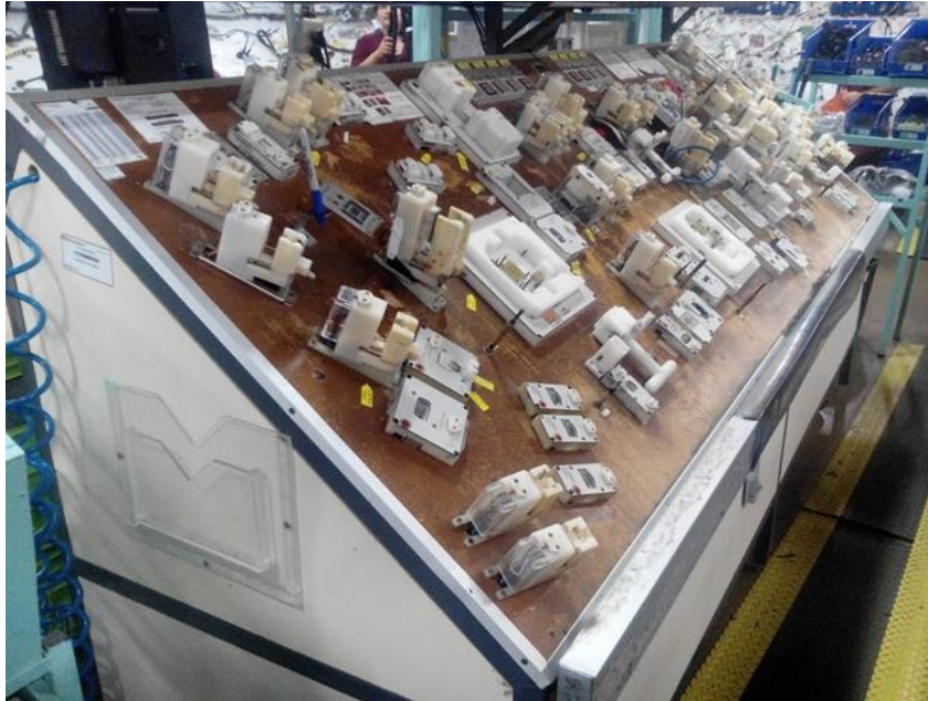
Ilustración 25 Tableros de Pruebas Eléctricas
