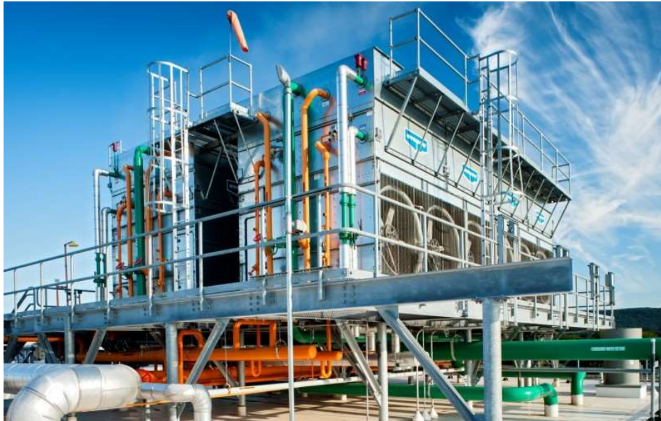
Ilustración 7 Condensador EVAPCO Fuente: EVAPCO
