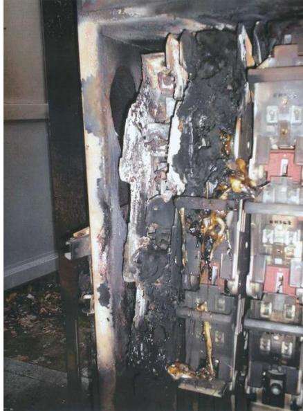
**Ilustración 18. Componentes quemados por falso contacto**
