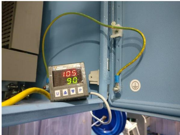
**Ilustración 28. Prueba de la PT100 de la Secadora**
