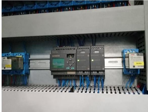
**Ilustración 21. Instalación del logo en el panel eléctrico de la secadora LAVATEC**
