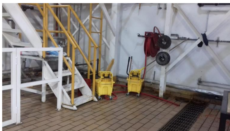
Ilustración 42 Gradas utilizadas para la limpieza de moldes.
