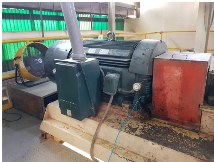
Ilustración 12 Motor del molino Altima, 300Hp con velocidad máxima de 3600 rpm.
