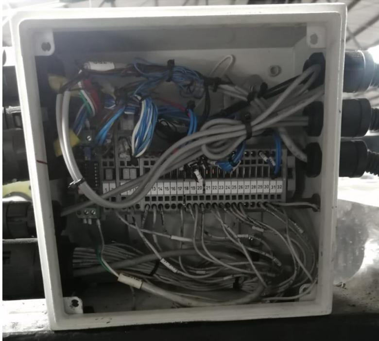
**Ilustración 18. Conexión de borneras completa**
