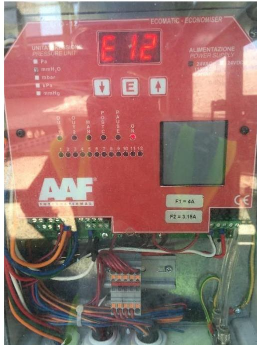
**Ilustración 21.** Contactor Inteligente para control de Electroválvulas.
