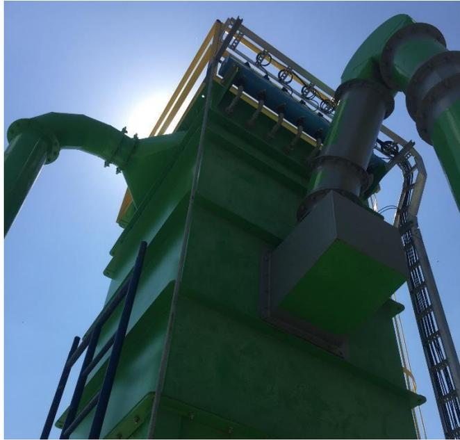
**Ilustración 37.** Tolva con electroválvulas, para fluidificación de material.
