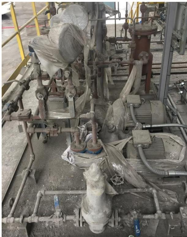
**Ilustración 15.** Estación de diesel recién montada.
