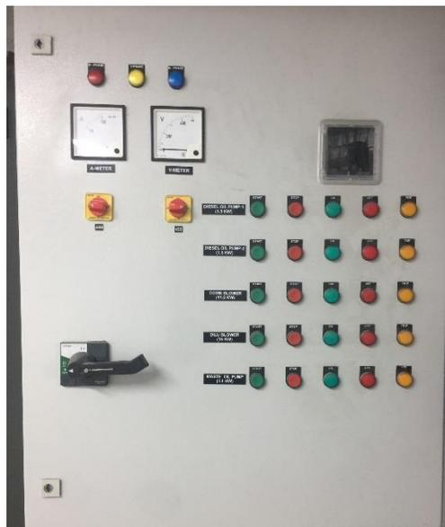
**Ilustración 34.** Panel de Control de Motores.
