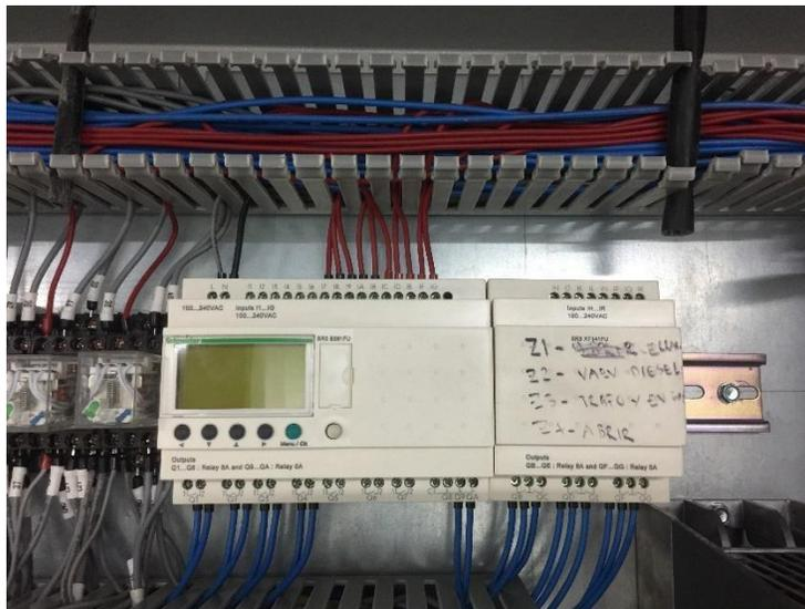
**Ilustración 20.** Zelio Cableado en el Panel de control.
