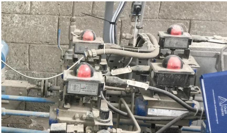
**Ilustración 12.** Válvulas Inteligentes de control de flujo.
