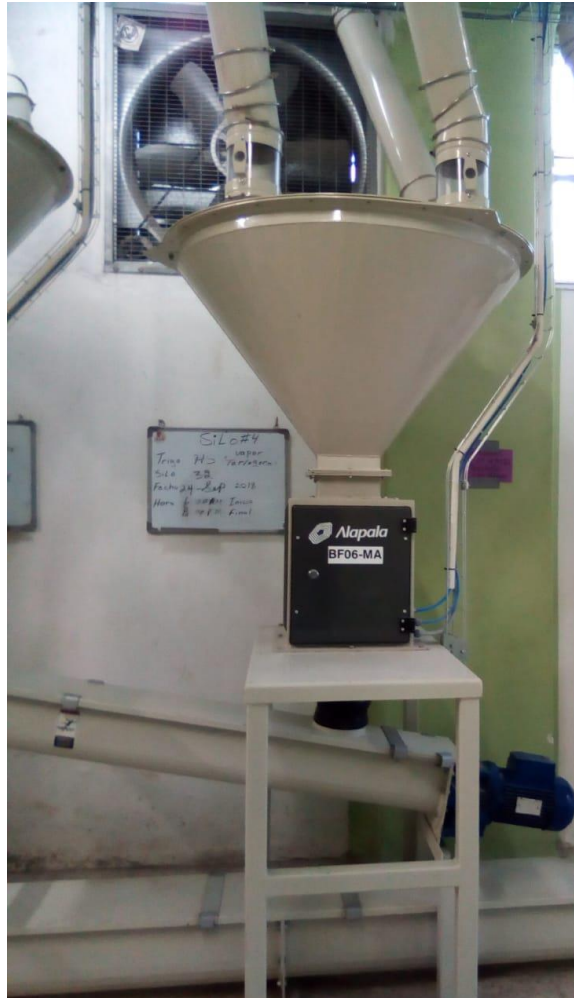
Ilustración 12. Dosificador de molino anexo, sistema de rosca y tolva de recepción.
