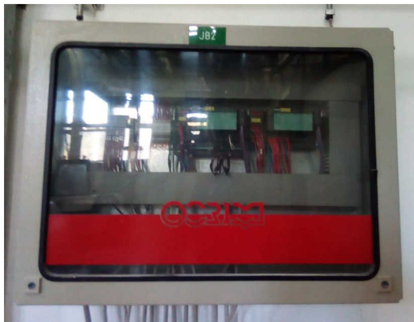
Ilustración 8. Periferia con comunicación profibus
