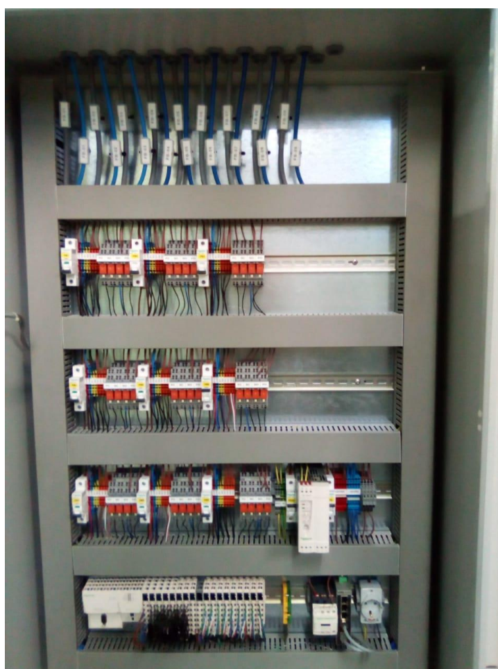
Ilustración 13. Panel de mando para dosificadores
